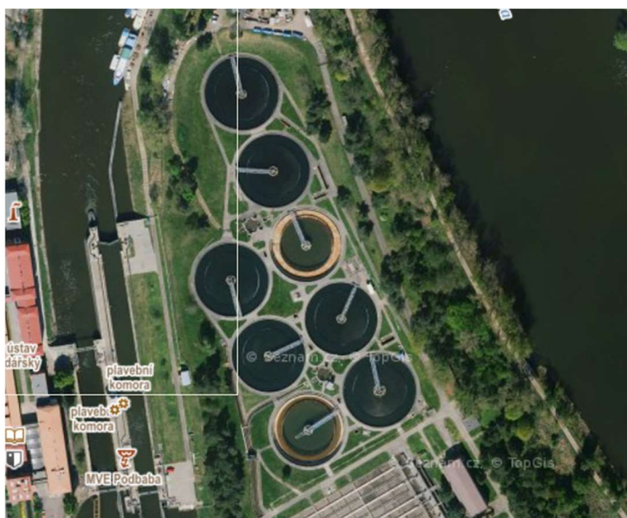
usazovací nádrže čističky odpadních vod
