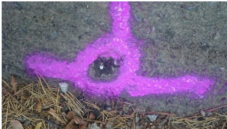
Obrázek 4.2: Ukázka dočasné stabilizace nastřelovacím hřebem.
