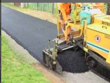
Zhotovení nové povrchové vrstvy místních komunikací
