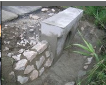
Čištění a opravy propustků, rigolů, šachet, vpustí
