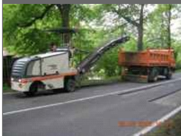
Vysprávka teplou asfaltovou směsí do upravených výtluků
