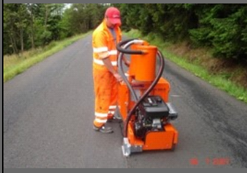
Sanace spár a trhlin
