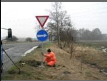
Svislé dopravní značení, jejich opravy, rovnání, výměna poškozených částí, zřizování
