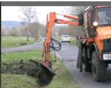
Čištění a opravy příkopů
