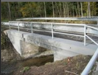
Údržba a opravy mostů
