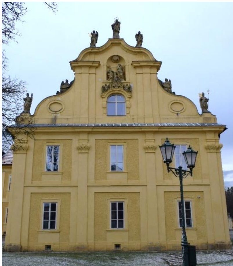
Obr. 10 Štít na západní fasádě barokního konventu.
