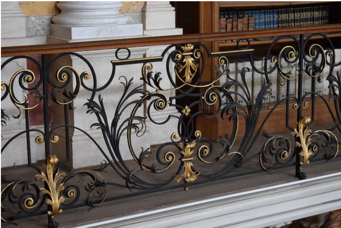
Obr. 97 Zábradlí druhé galerie. Foto: Filip Vašků, 2023.
