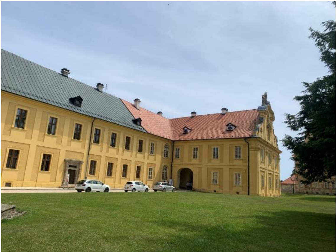
Obr.7 Barokní část kláštera, západní fasáda.
