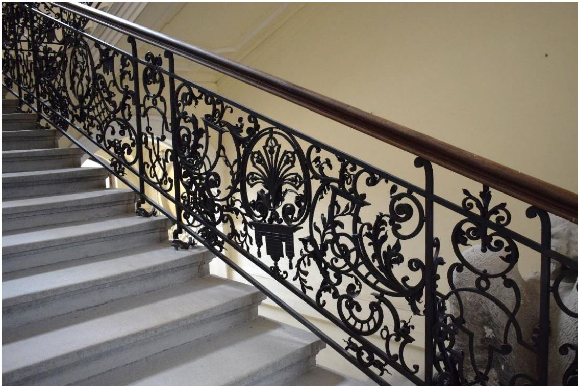
Obr. 109 Zábradlí u severního schodiště mezi knihovnou a muzeem.
