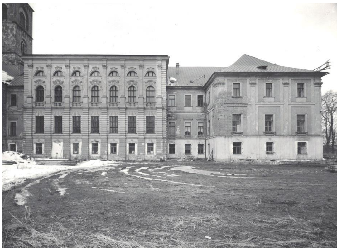
Obr. 131 Pohled na poničenou východní fasádu novostavby.
