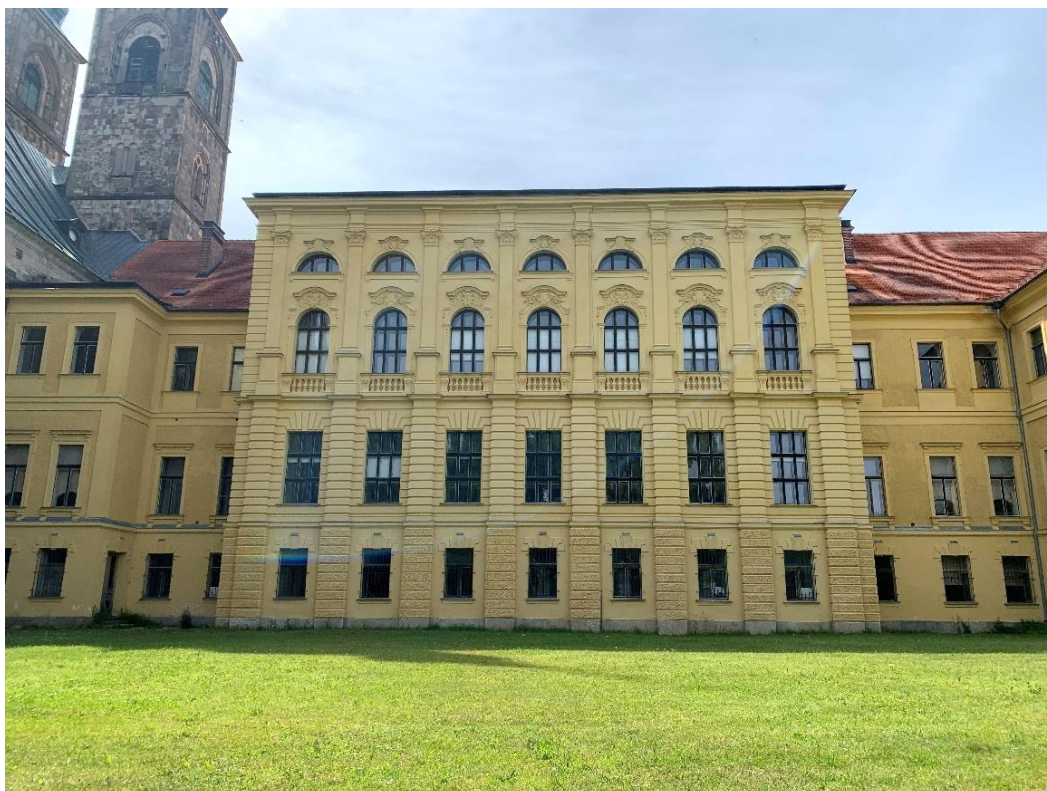
Obr. 43 Rizalit knihovního sálu na východní fasádě.
