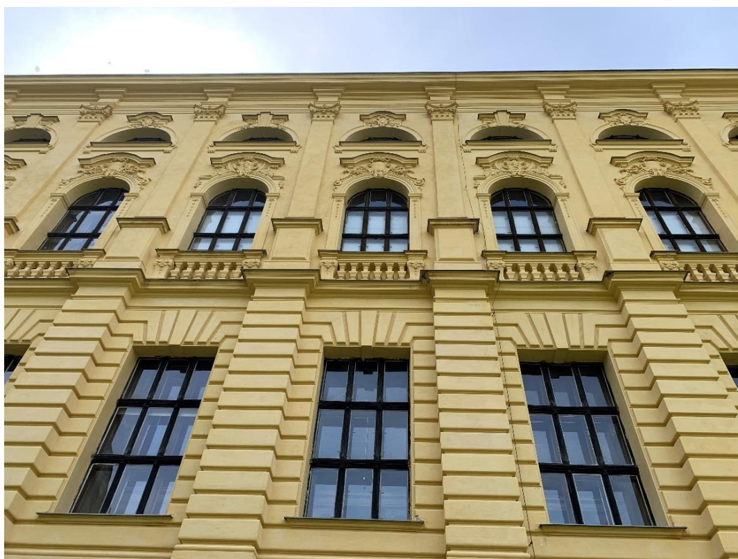
Obr. 44 Detail členění fasády rizalitu.
