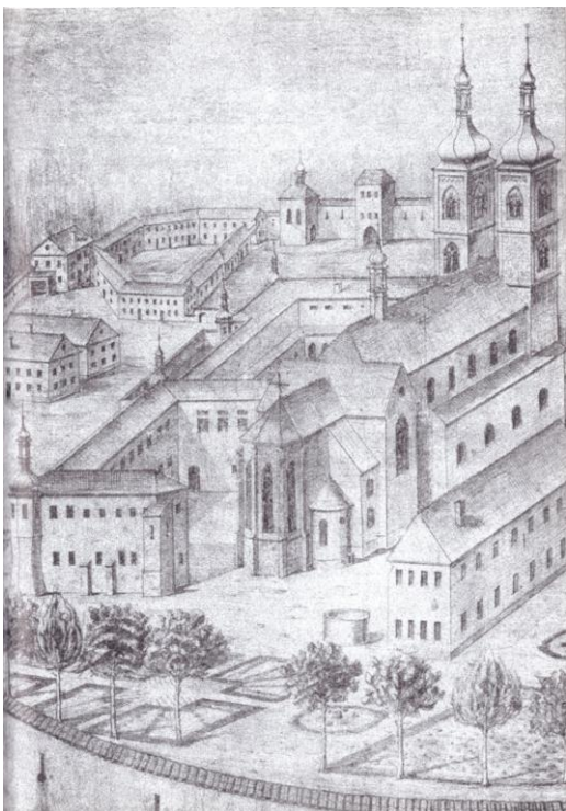
Obr. 3 Klášter od východu z roku 1665 před barokní přestavbou.
