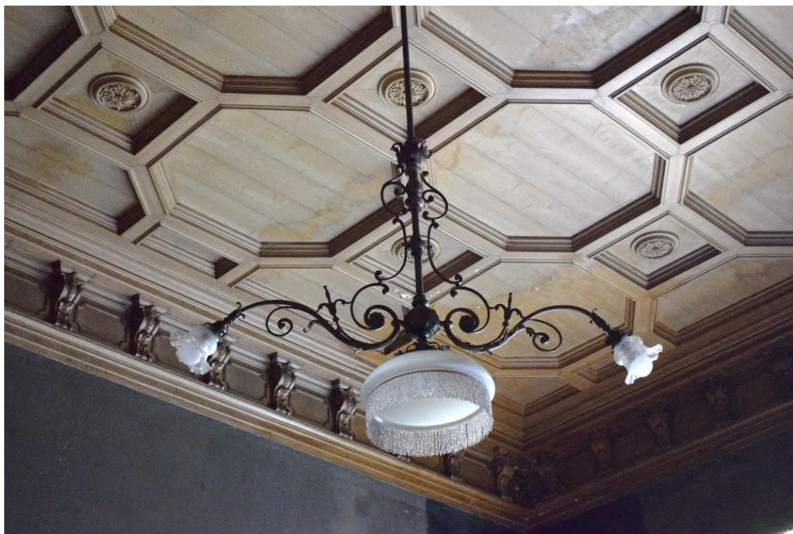
Obr. 102 Detail kazetového stropu čítárny s lustrem.
