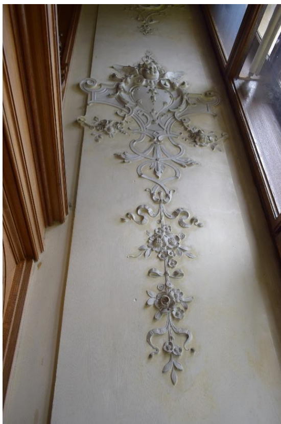
Obr. 67 Štuková výzdoba na okenních ostěních, pohled z přízemí.
