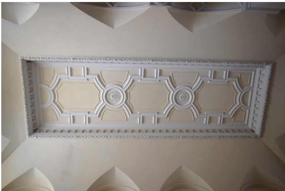
Obr. 112 Strop schodišťového prostoru.
