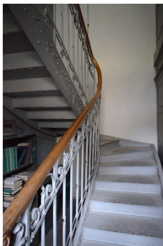
Obr. 105 Schody v roštovém depozitáři.
