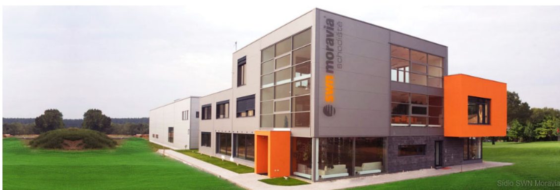
Obrázek 11: Nová administrativně-výrobní budova z roku 2008
