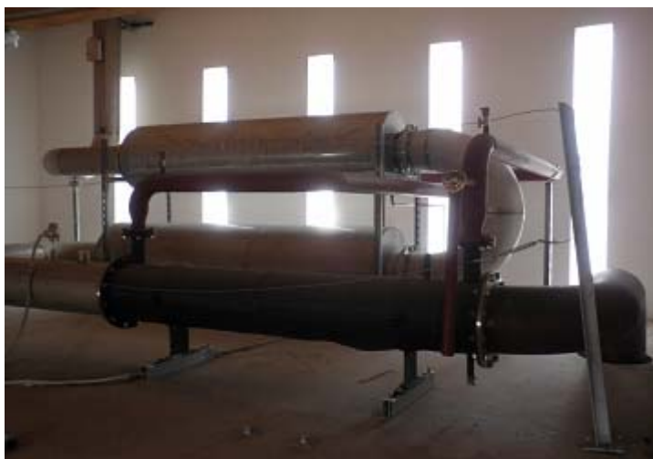
Obr.4. 5 Spalinový výměník s tlumiči hluku
