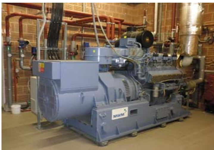
Obr.4. 3 KJ se zážehovým motorem MWM - TCG 2016 V12 C
