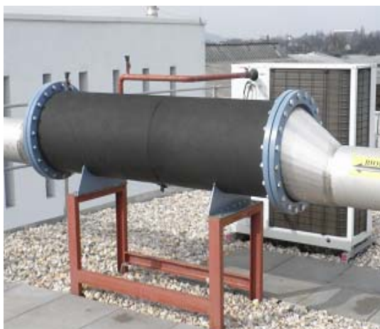
Obr.4. 1 Trubkový výměník (odstranění vodní páry)
