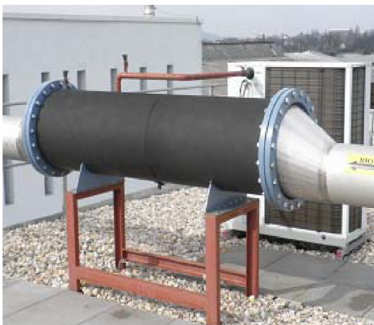
Obr.4. 1 Trubkový výměník (odstranění vodní páry)
