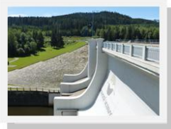
Hráz Lipenské přehradní nádrže
