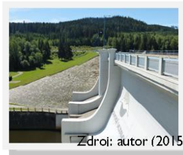
Hráz Lipenské přehradní nádrže
