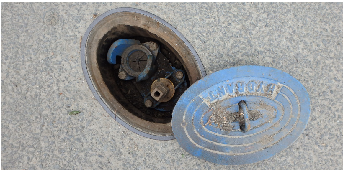
Obr. 9 Podzemní hydrant v ulici Kouty.
