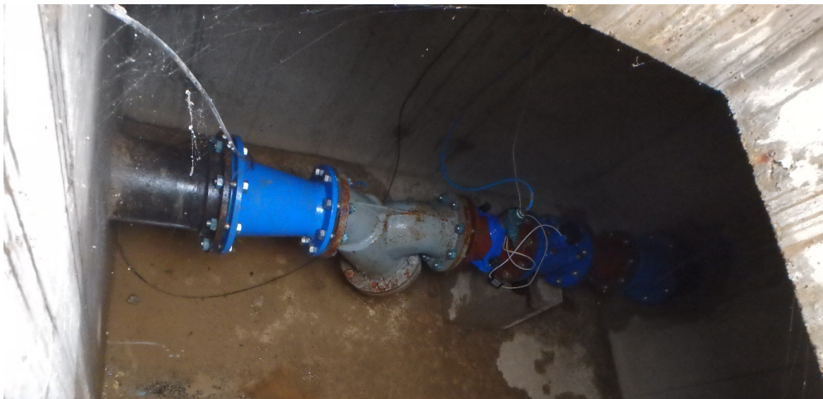
Obr. 29 Vodoměr na odbočce z Březovského přivaděče.
