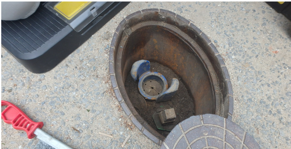
Obr. 17 Podzemní hydrant na ulici Zatloukalova.
