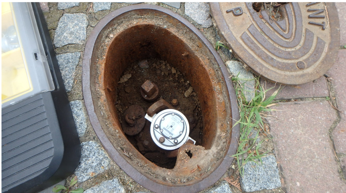
Obr. 22 Osazena měřicí technika značky Seba KMT.
