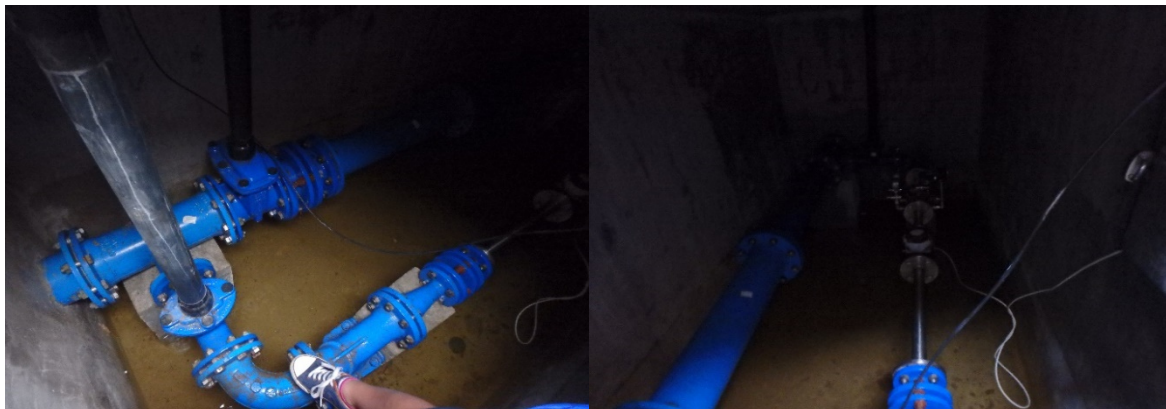
Obr. 32 Pohled do šachty s osazeným redukčním ventilem (vlevo). Redukční ventil CLA-VAL (vpravo).
