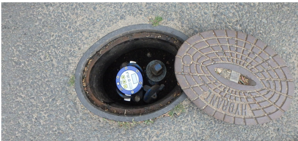
Obr. 13 Podzemní hydrant v ulici Mácova.
