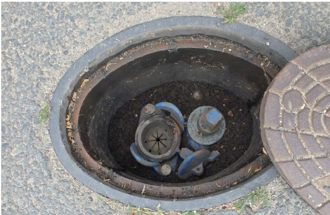
Obr. 13 Podzemní hydrant v ulici Mácova.
