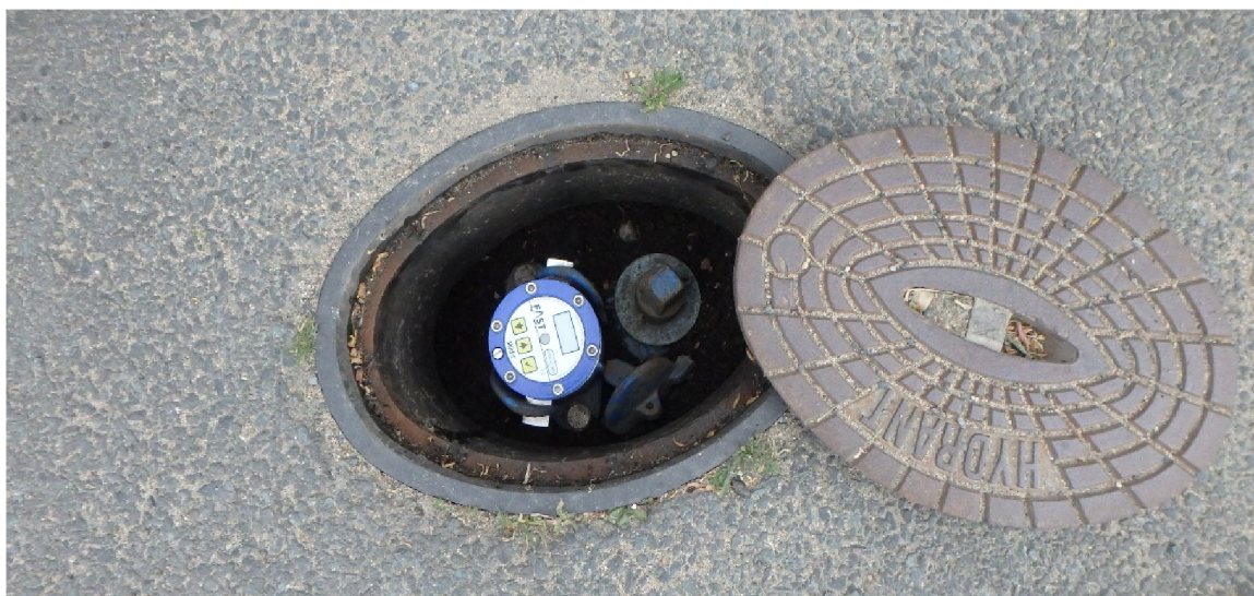
Obr. 13 Podzemní hydrant v ulici Mácová.
