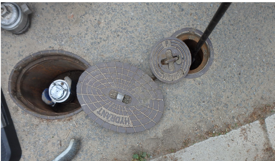
Obr. 17 Podzemní hydrant na ulici Zatloukalova.
