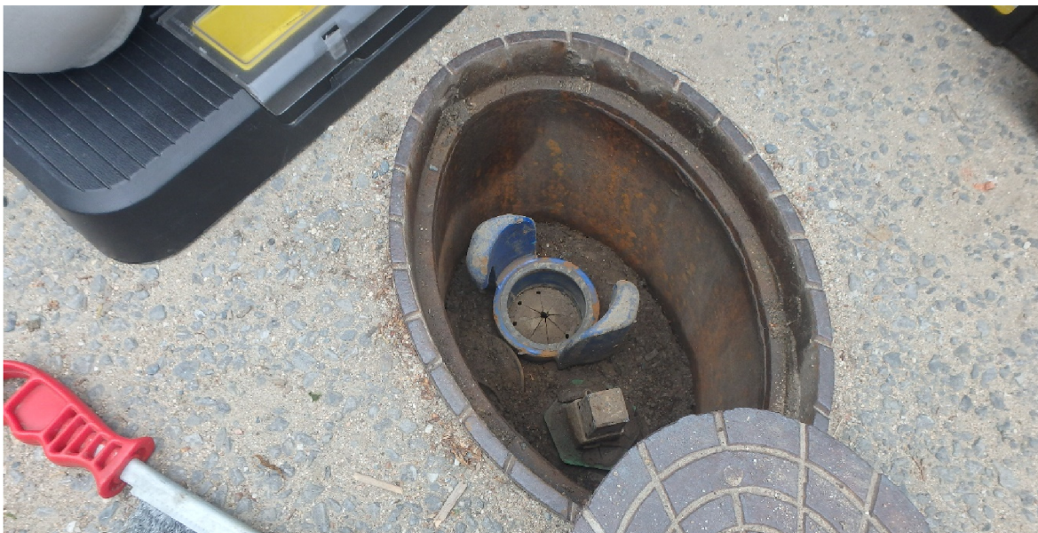
Obr. 17 Podzemní hydrant na ulici Zatloukalova.
