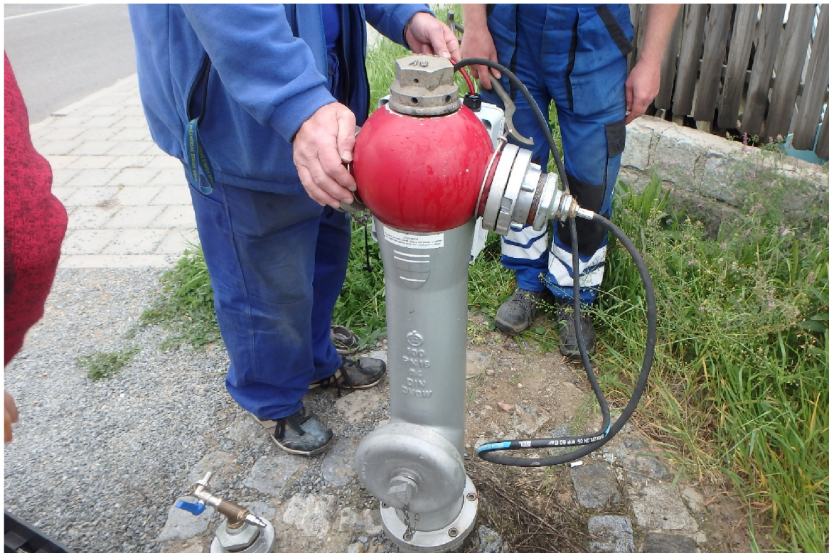
Obr. 25 Nadzemní hydrant na ulici Černohorská.
