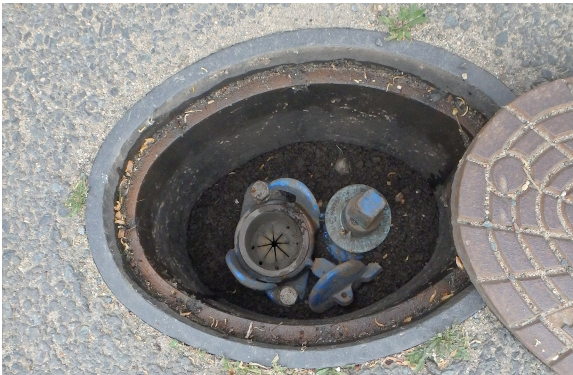
Obr. 13 Podzemní hydrant v ulici Mácová.
