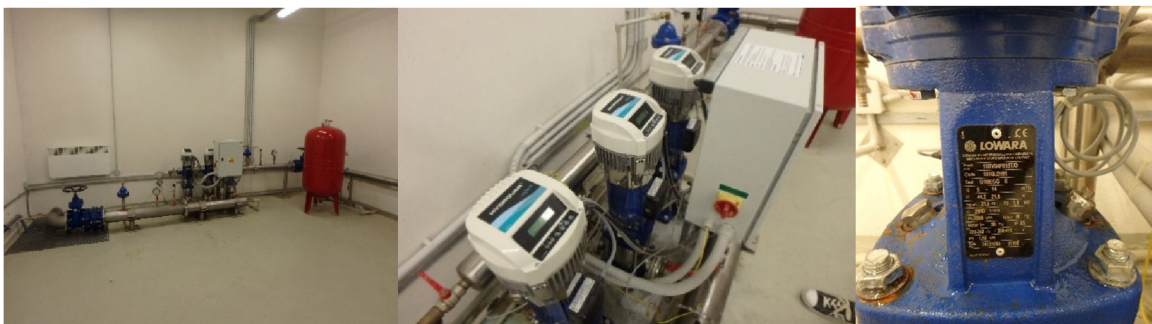
Obr. 6 Pohled na ČS stanice (vlevo), pohled na tři čerpadla (uprostřed), štítek s technickými parametry na čerpadle (vpravo).
