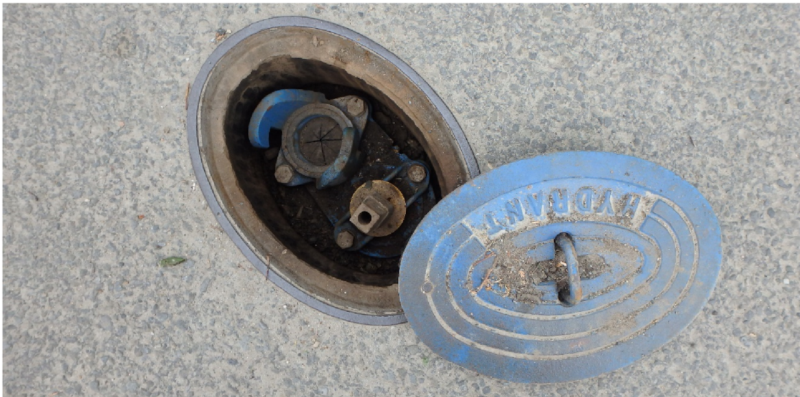
Obr. 9 Podzemní hydrant v ulici Kouty.
