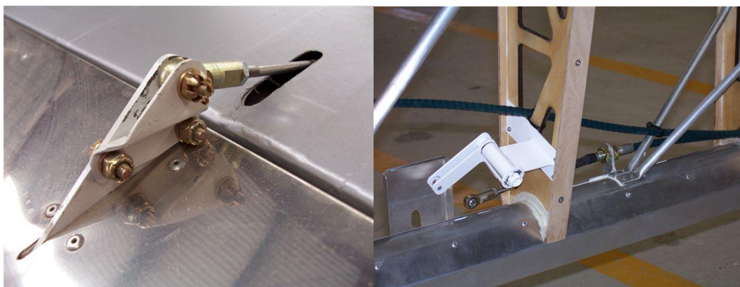
Obr. 4: Pohled na táhlo klapky (1. pohled z venku; 2. pohled na konstrukci křídla) 2
