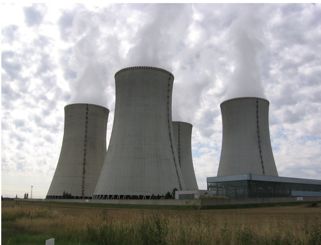
Obrázek 2.1 – Chladicí věže jaderné elektrárny dukovany autor: Stanislav Rada, 2006
