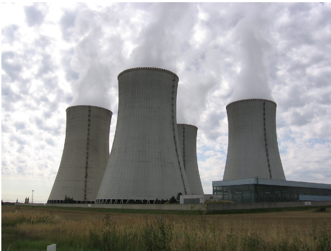
Obrázek 2.1 – Chladicí věže jaderné elektrárny dukovany autor: Stanislav Rada, 2006
