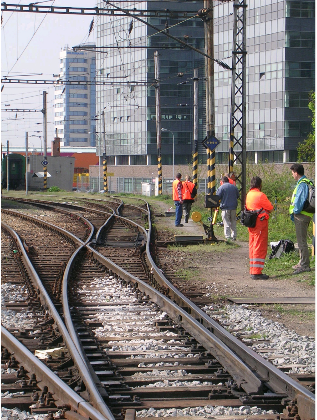
Obrázek 20 Matečná kolej odstavného nádraží A v obvodu žst. Brno hl.n. - odbočení na kolej č. 667
