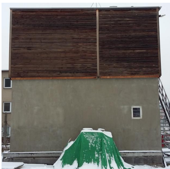
Obrázek 10.1 - Fotodokumentace experimentální dřevostavby
