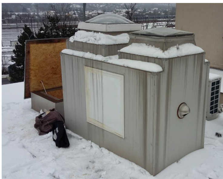
Obrázek 10.7 - Schéma měřeného světlovodu a pohled na světlovodné kopule na střeše budovy
