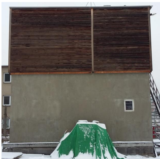
Obrázek 10.1 - Fotodokumentace experimentální dřevostavby
