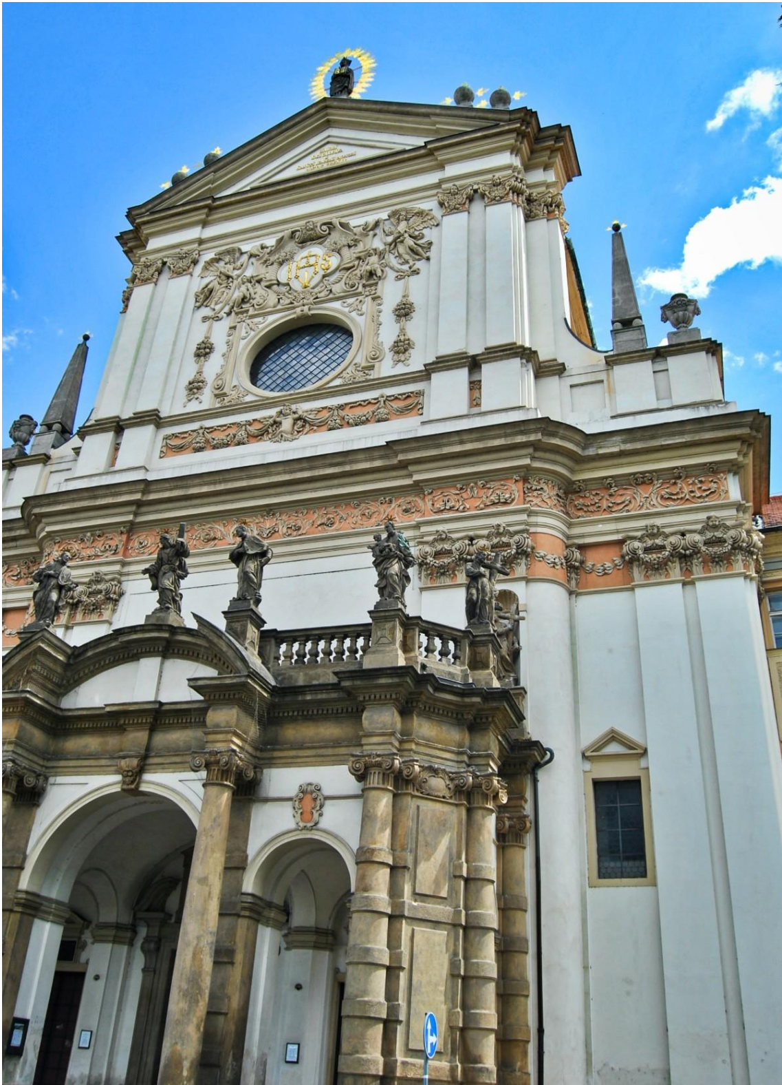
39. Kostel sv. Ignáce z Loyoly, Praha
