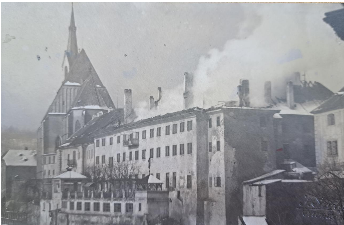
12. Požár hotelu Růže v Českém Krumlově, pohled na hotel z jednoho z domů v ulici Rooseveltova, 1919
