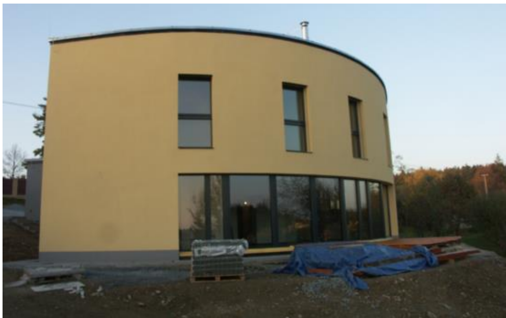
Obr. 16 Jihozápadní pohled při výstavbě, zdroj: elam.cz 56)
