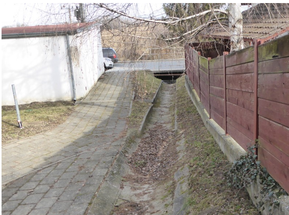
Obr. 10 Vtok pod silniční komunikací 416 [10]
