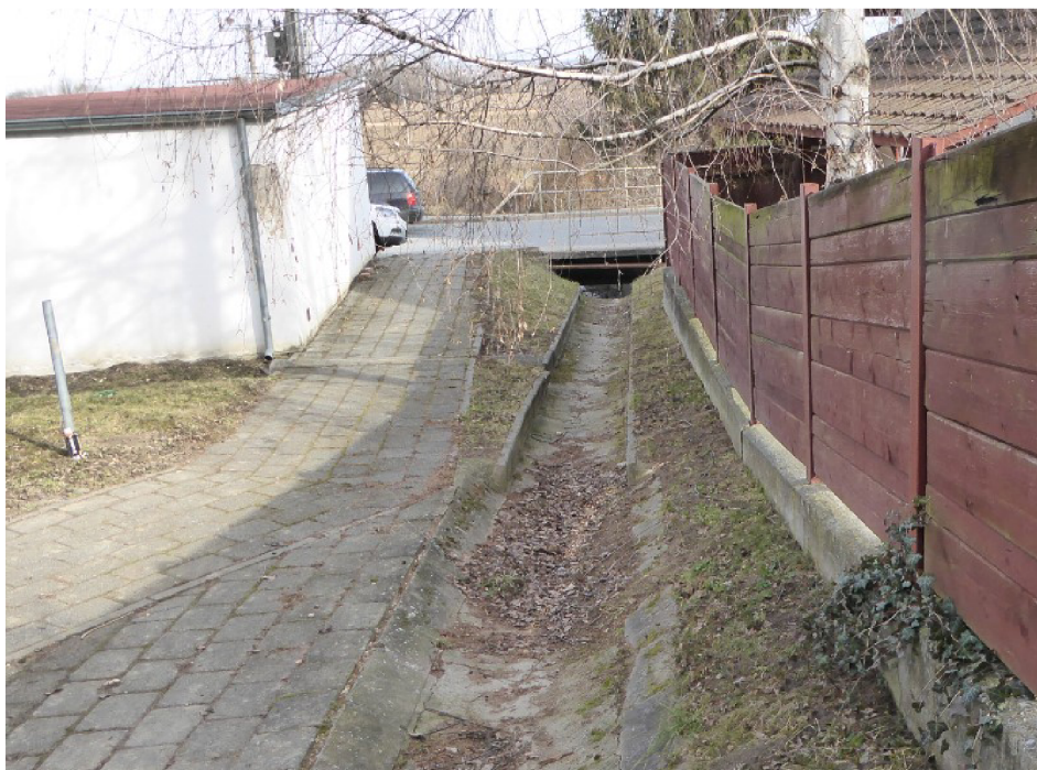
Obr. 10 Vtok pod silniční komunikací 416 [10]
