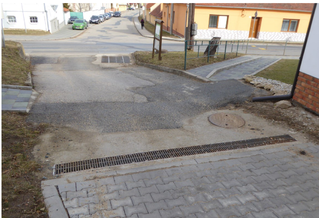
Obr. 11 záchytný rošt pod profilem č. 6 nedaleko Blučinského kostela [10]
