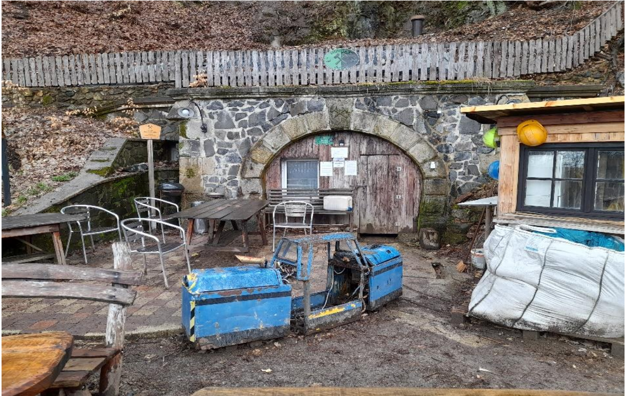
Obr. 15: Štola Lehnschaffer Zdroj: Rozálie Kubišová, 2023
