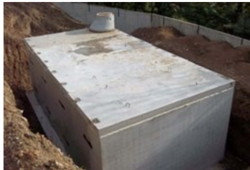
Obrázek č.21: Betonová nádrž. [34]
