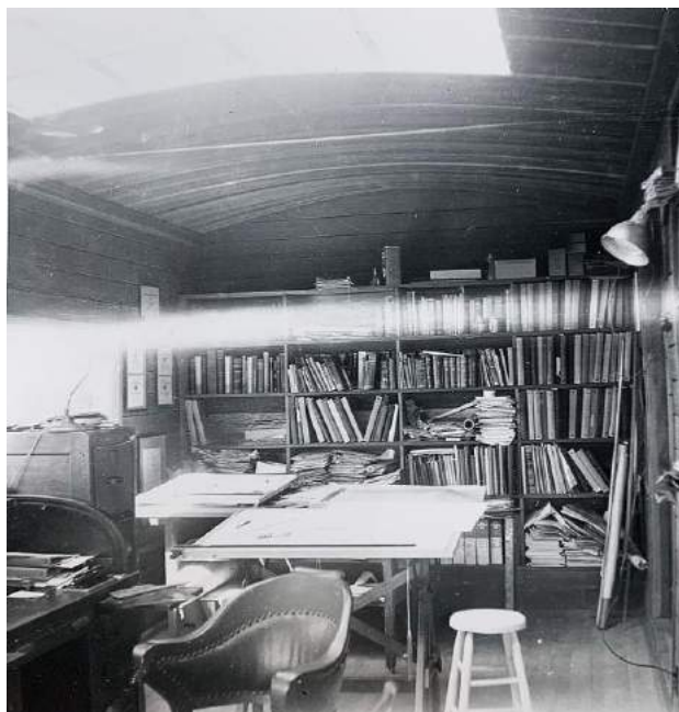
Obr. 32 Pracovna Jaroslava Polívky se světlíkem v domě 1150 na Arch Street v Berkeley, po 1946, ARVP
