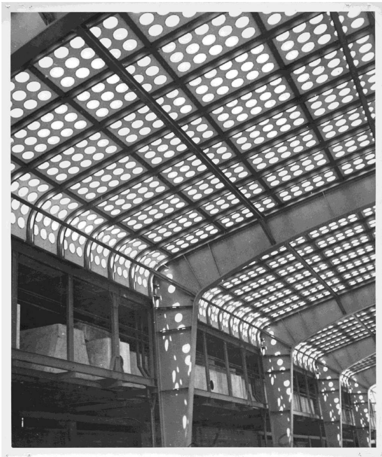
Obr. 12 Uplatnění sklobetonových tvárnic Thermolux v zaklenutí haly burzy obilovin v Rotterdamu, 1935–1940, dobový tisk
