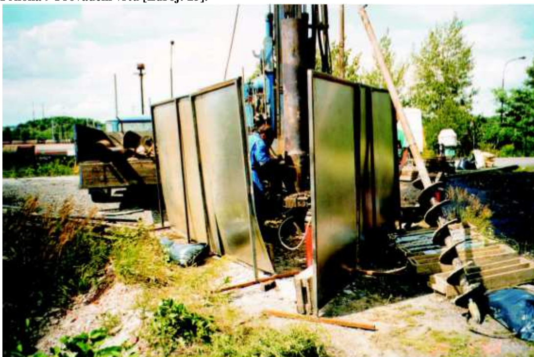
Příloha 9 Provádění vrtů [Zdroj: 25].
