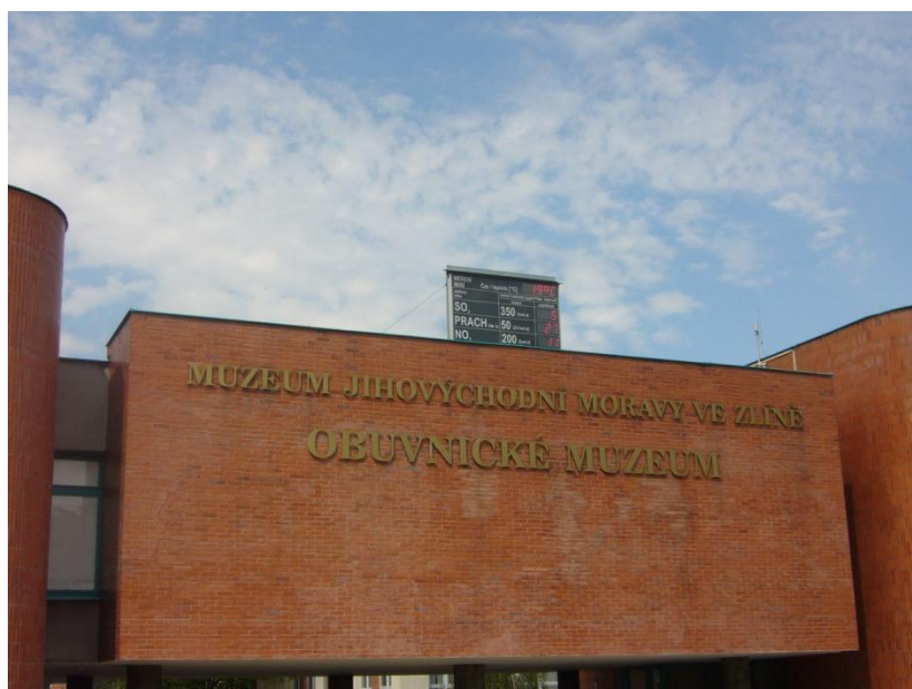
Obr. 25 Měřicí stanice Svit (zdroj: foto M. Halíčková)
