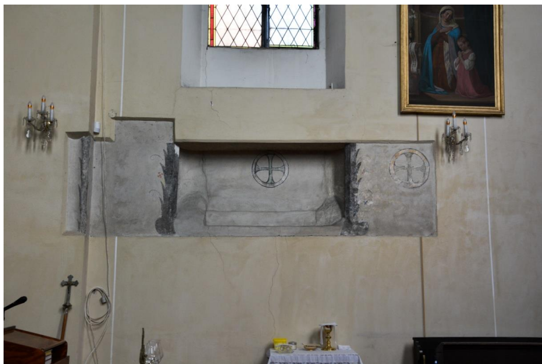
18. Sezemice, kostel Nejsvětější Trojice, presbytář, zachovaný zbytek podokenní římsy
