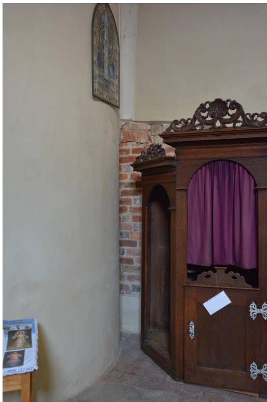
21. Sezemice, kostel Nejsvětější Trojice, původní cihlové zdivo, severní strana kostela
