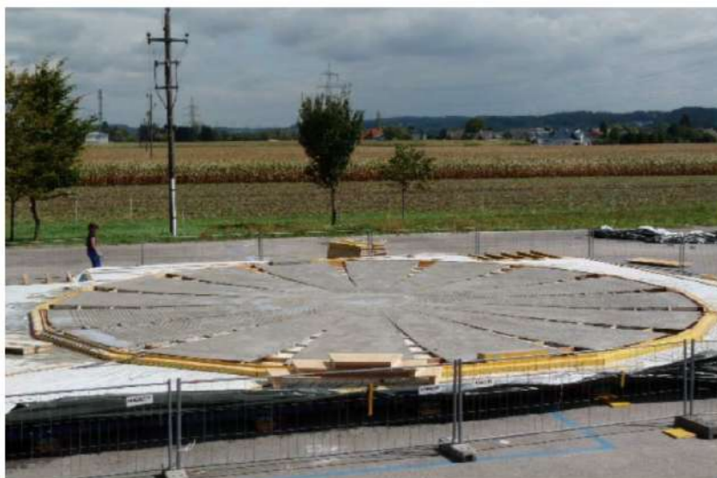
fig.4 Zvedání betonové sférické skořepiny pomocí PFHC, 2012, Rakousko.
