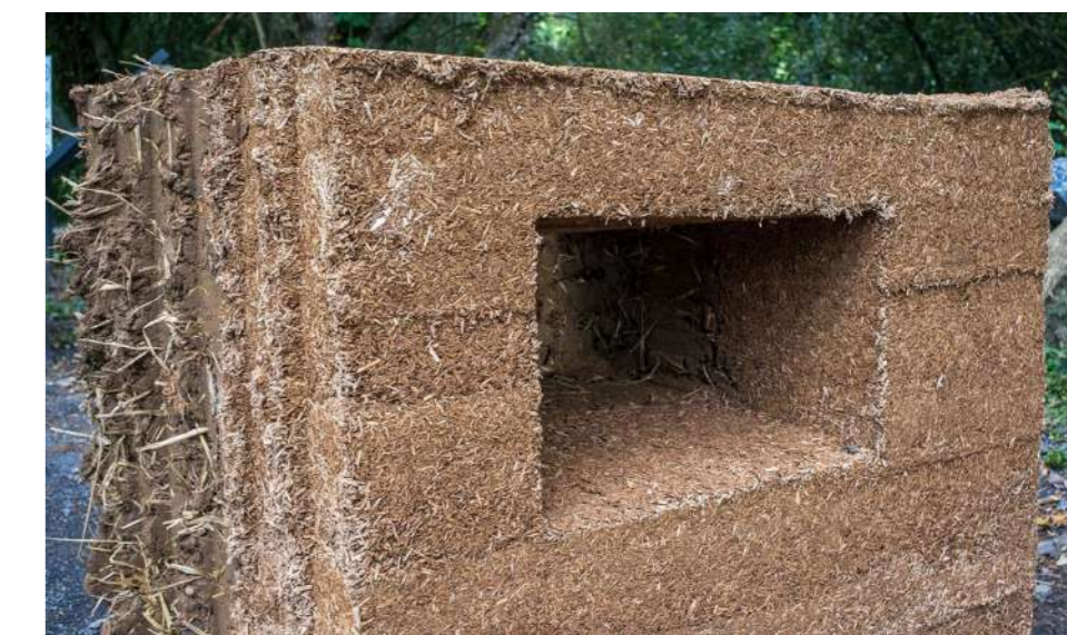
Stěna z cobu (1)
