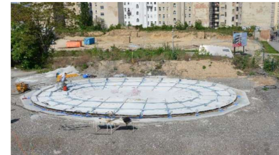
fig.5 Zvedání betonové sférické skořepiny pomocí PFHC, 2014, Pokus ve Vídni, Rakousko. (12)
