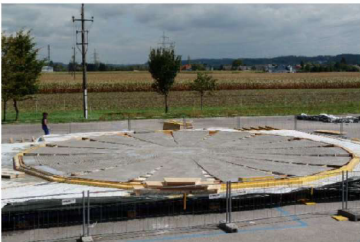
fig.4 Zvedání betonové sferické skepřiny pomocí PFK, 2012, Rakousko.
