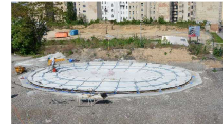
fig.5 Zvedání betonové sferické skepřiny pomocí PFK, 2014, Pokus ve Vídni, Rakousko. (a)
