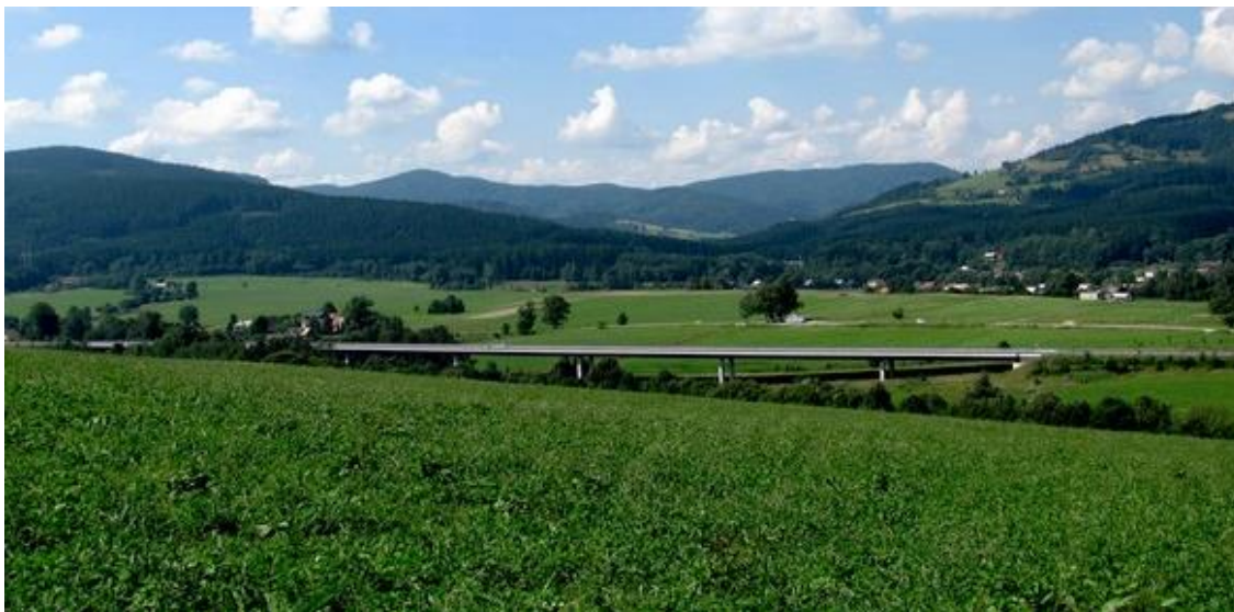
Obr. 15. - Příklad migrační podchodu u Jablunkova, spojující lesní komplexy Moravskoslezských a Slezských Beskyd. Migrace zvířat ze Slovenska i Polska tudy může probíhat díky tomu, že zde velmi frekventovaná silnice I/11. Převzato z https://www.selmy.cz/ohrozeni/fragmentace-krajiny/jablunkovska-brazda/ .
