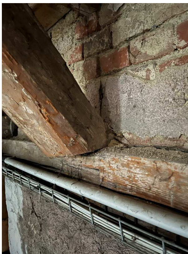
Obr. 8 Napojení krokve na pozednici v průčelí budovy
