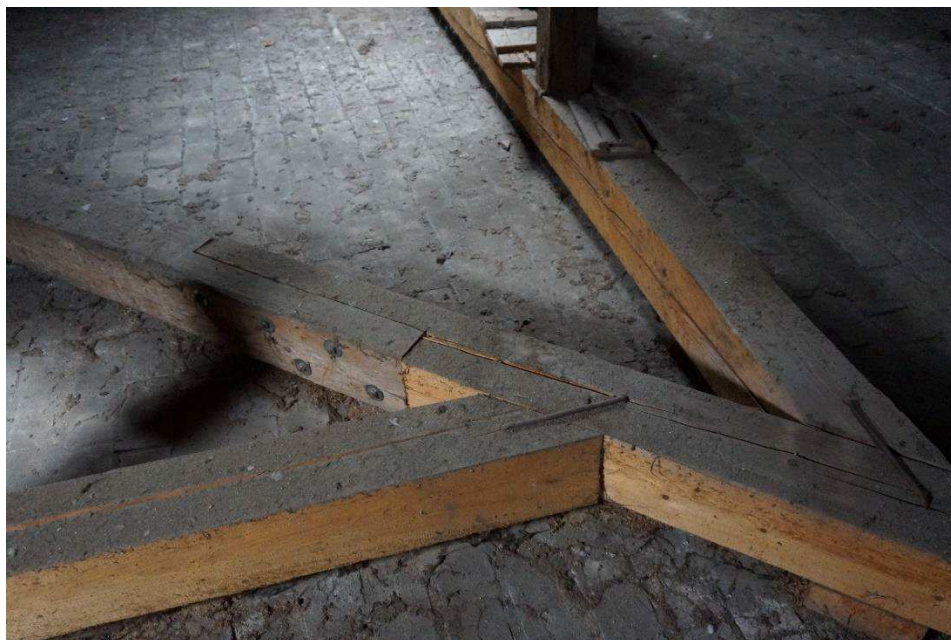
Obr. 11 Výměna spojení vazných trámů v rohu budovy
