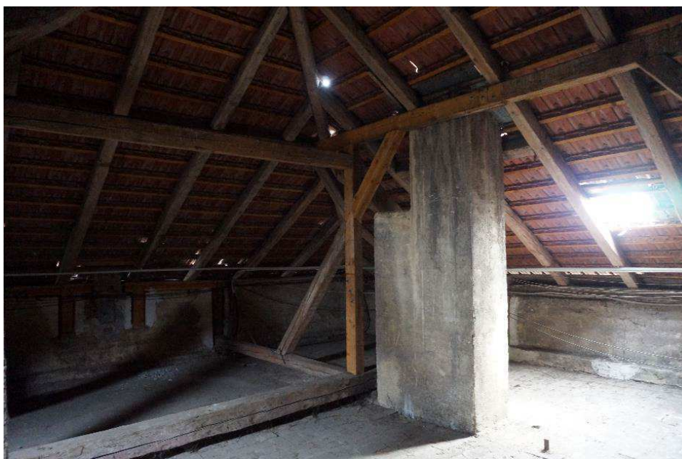
Obr. 10 Vyměněný sloup v levém křídle budovy
