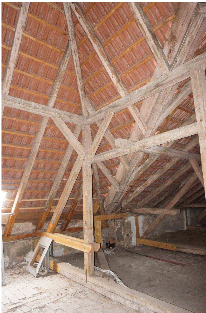
Obr. 12 Napojení vyšší a nižší střechy – vyměněné pozednice a spodní části krokví
