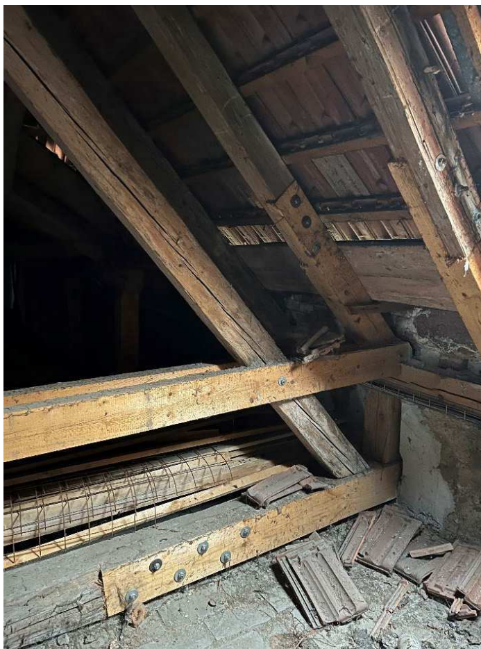
Obr. 13 Výměna pozednice, navazující části krokve a vazného trámu a obou kleštín
