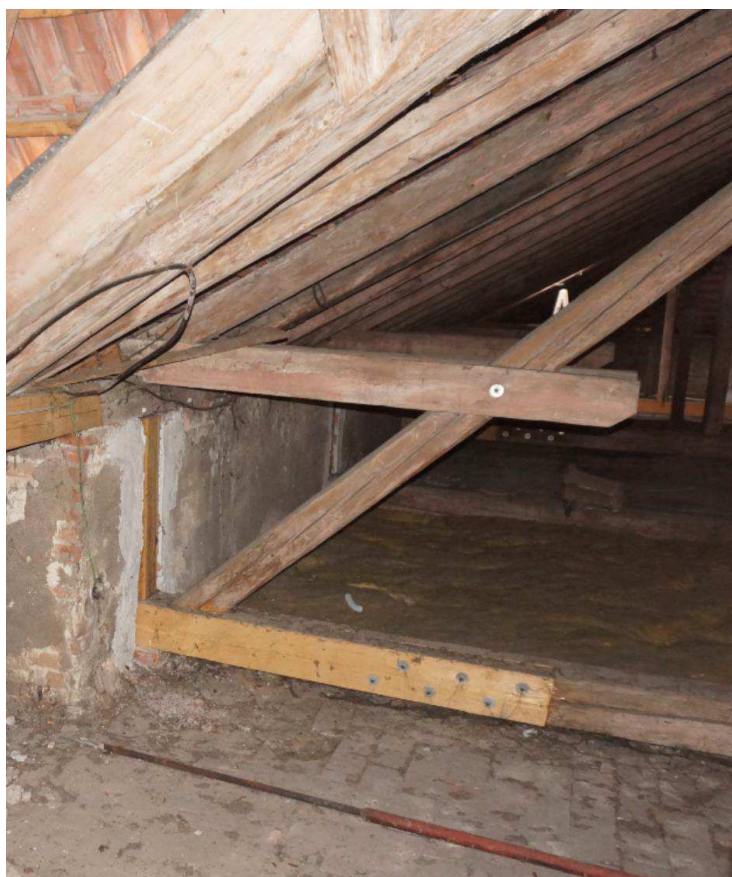
Obr. 9 Výměna uložení vazných trámů do obvodového zdiva
