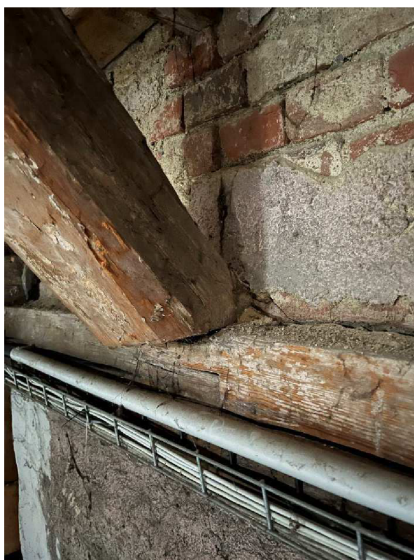
Obr. 8 Napojení krokve na pozednici v průčelí budovy
