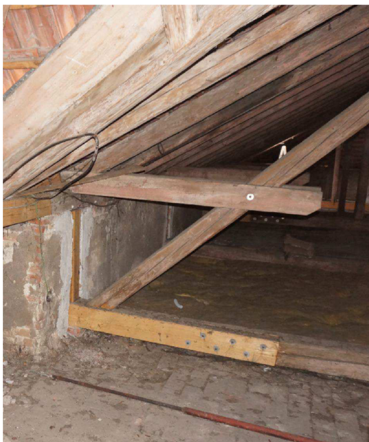
Obr. 9 Výměna uložení vazných trámů do obvodového zdiva
