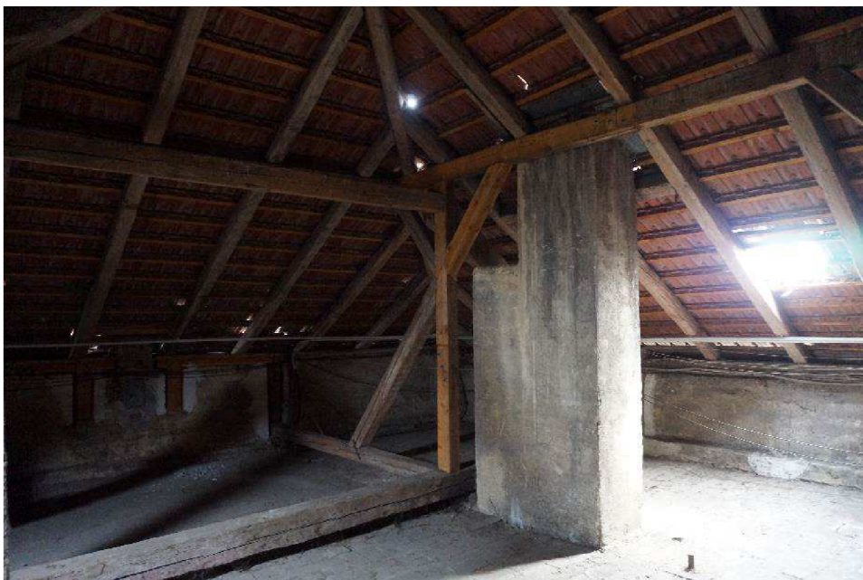
Obr. 10 Vyměněný sloup v levém křídle budovy
