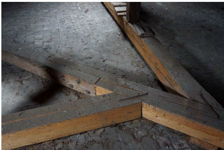
Obr. 11 Výměna spojení vazných trámů v rohu budovy
