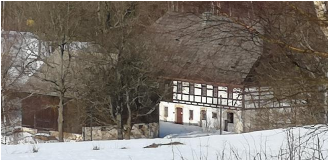
Obrázek 12: hrázděný dům v Mohelnici v Německu, vlastní foto
