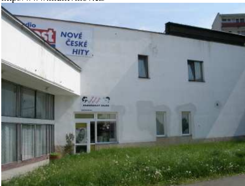
Obrázek č. 6 - Citadela – pohled na křídlo před rekonstrukcí http://www.mulitvinov.cz/
