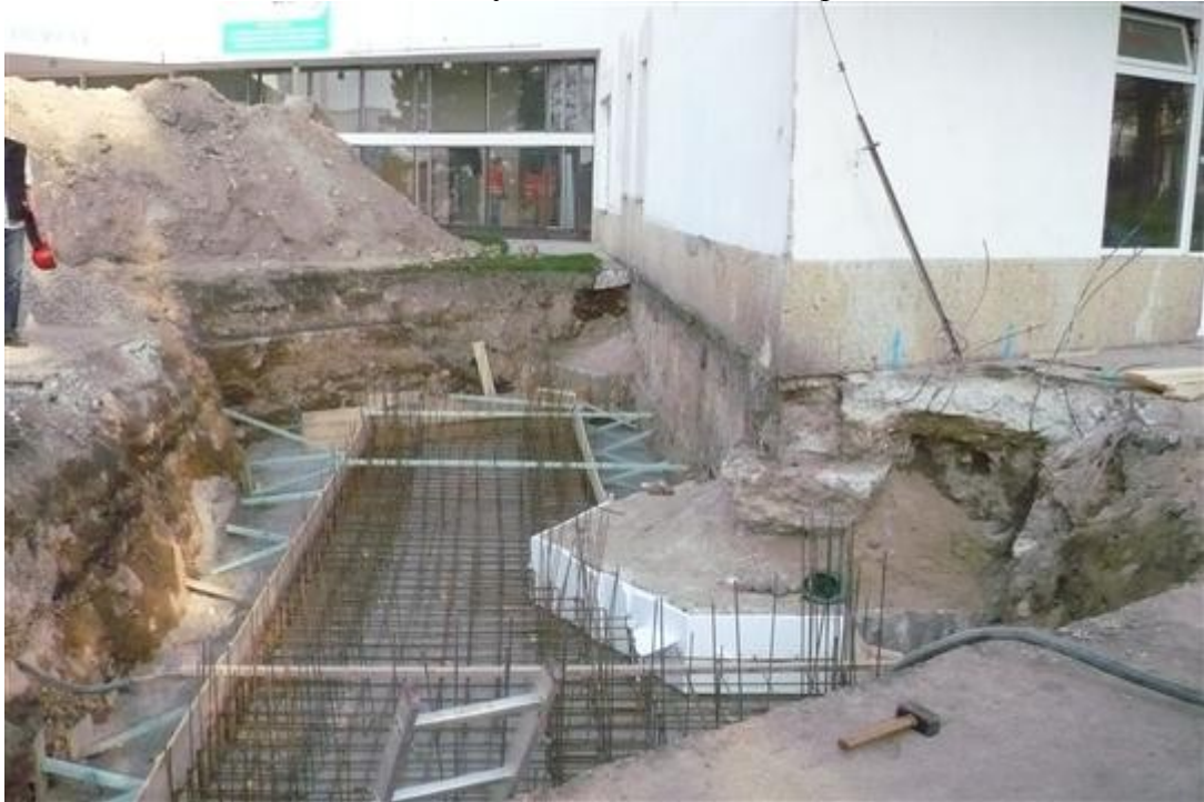
Obrázek č. 9 - Citadela – základy nového schodiště http://www.mulitvinov.cz/
