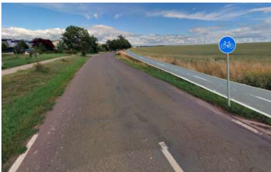
Obrázek 1: Vedení cyklostezky podél silnice III/2403
