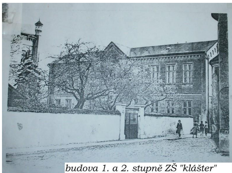
Obr. č. 2: Budova školy. 19
