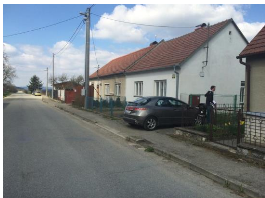
Obr. č. 2.5 Zastavěná část lokality
