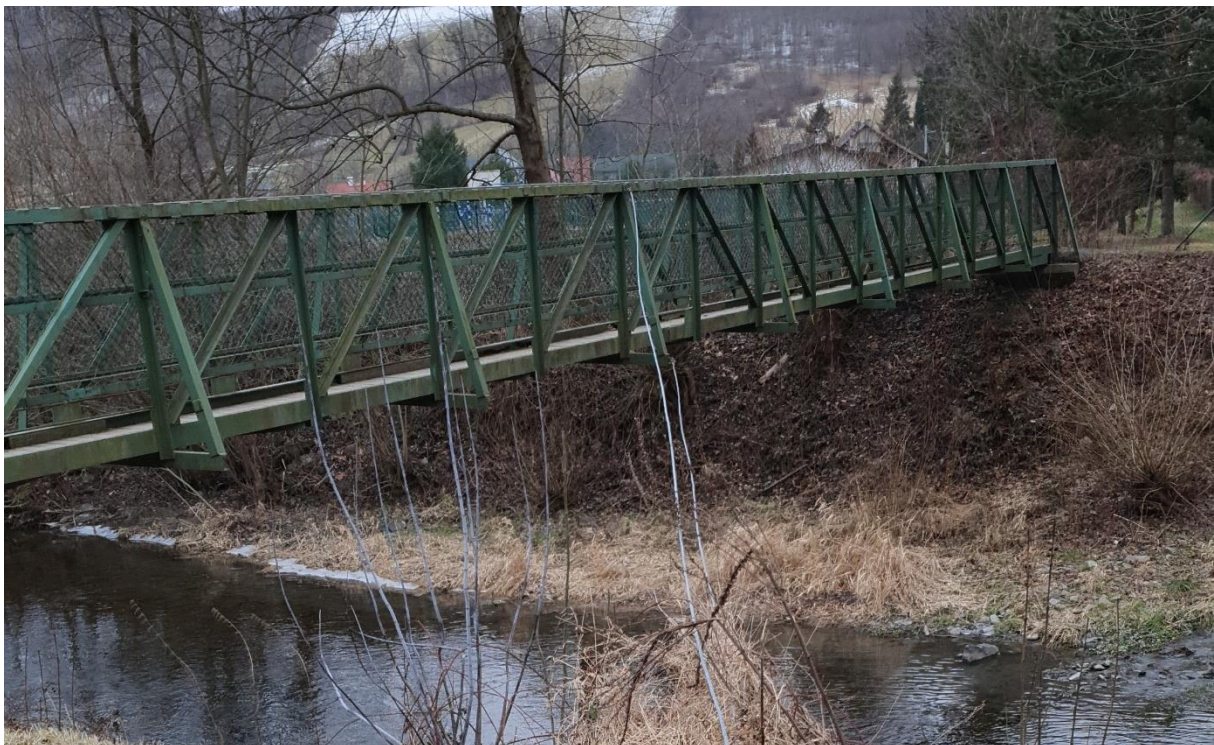
Obr. 2.1 – Zjištěná lávka (v ř. km 92,837)
