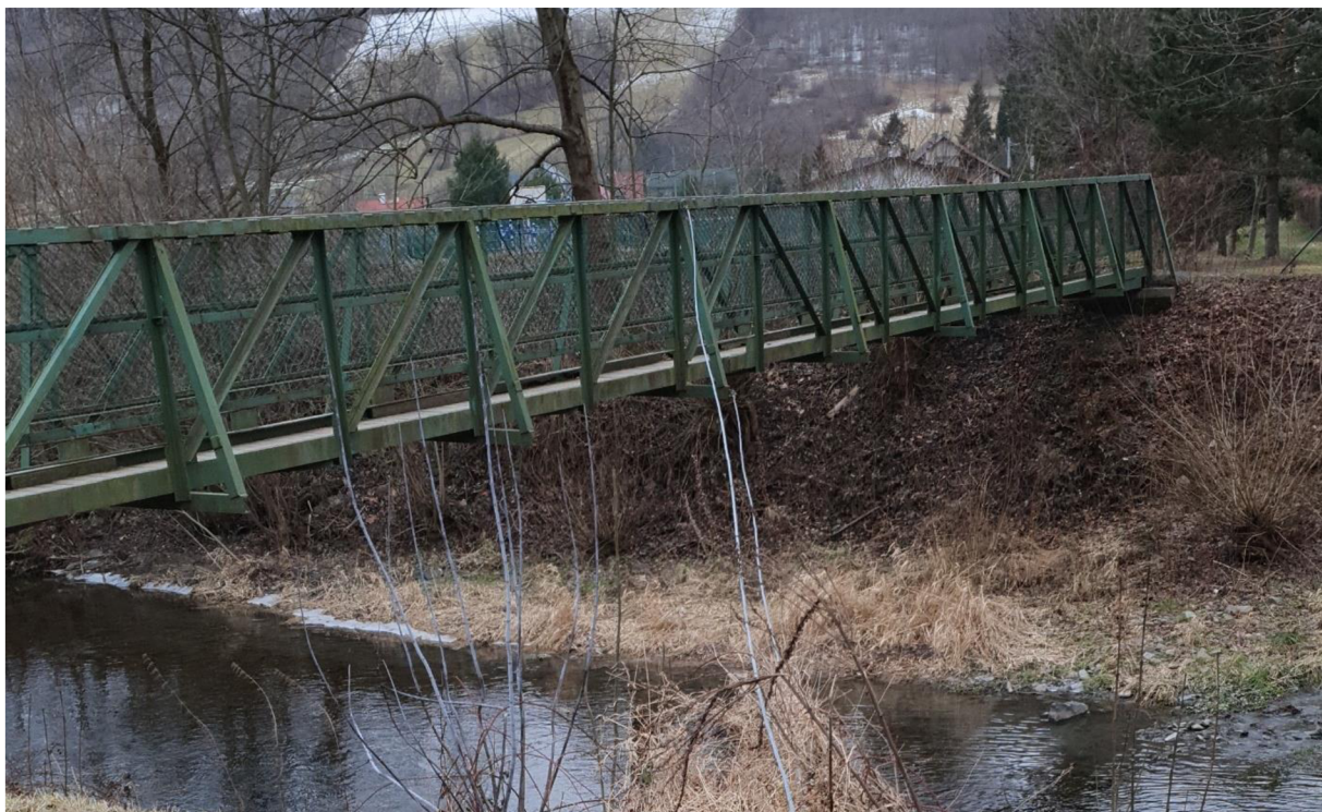
Obr. 2.1 – Zjištěná lávka (v ř. km 92,837)
