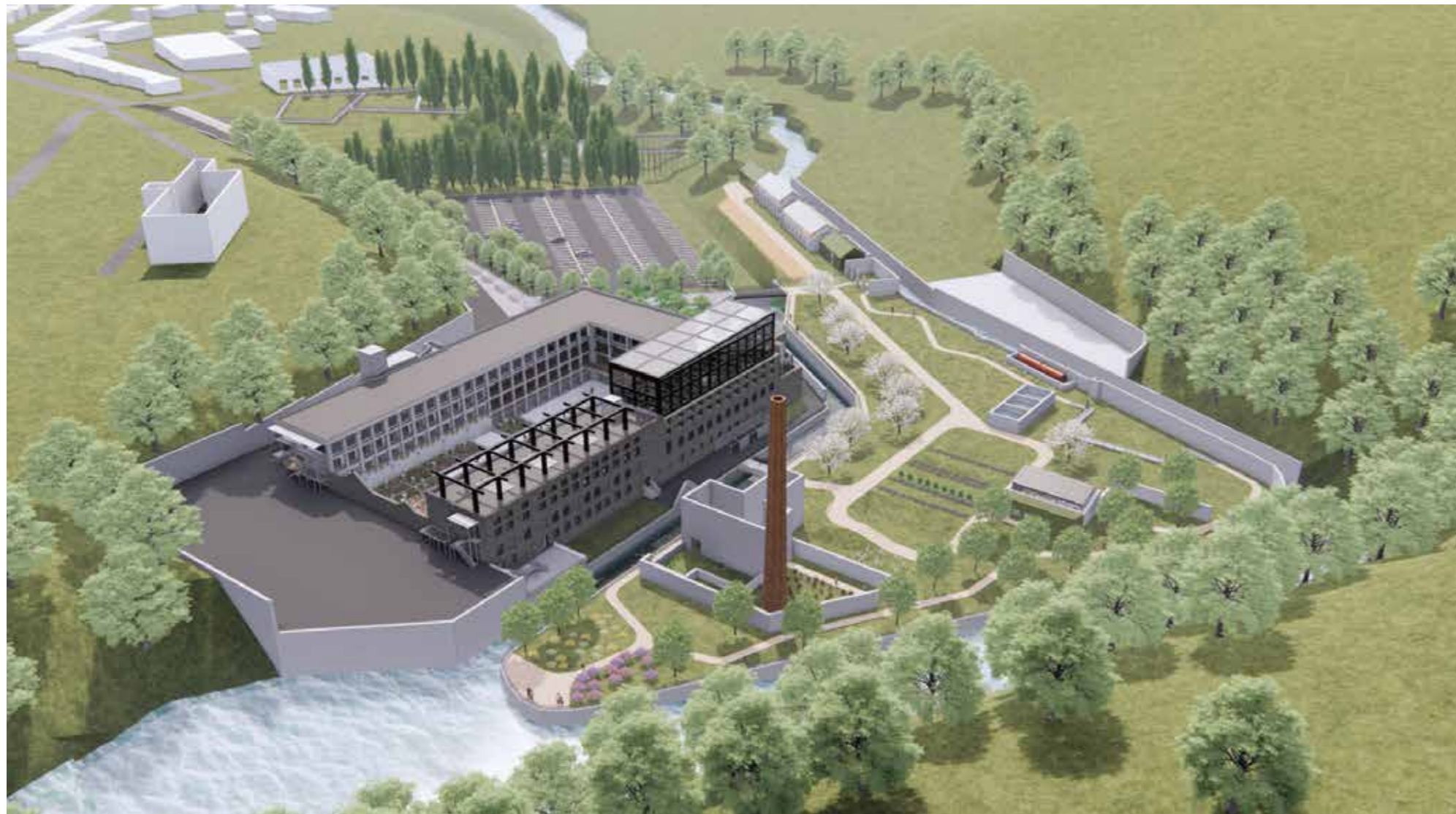
pohľad zo severozápadu
