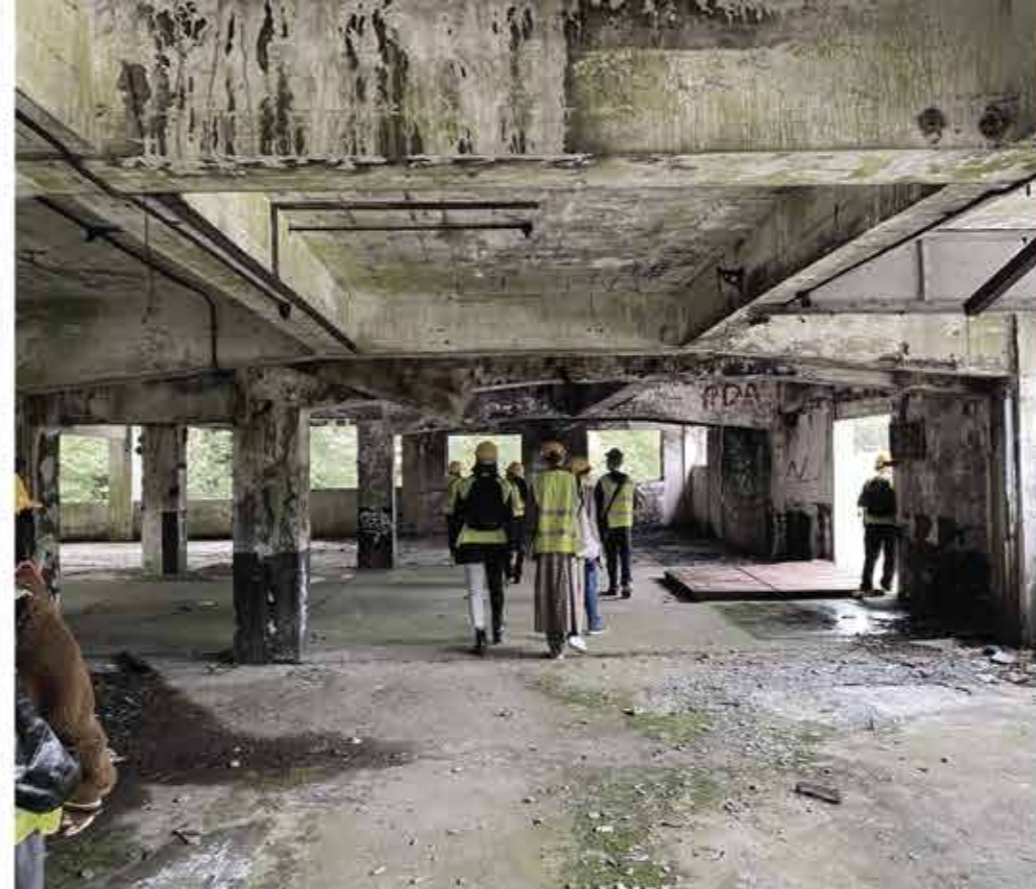
nosná konštrukcia spojovacieho kídla staršej a novej časti
