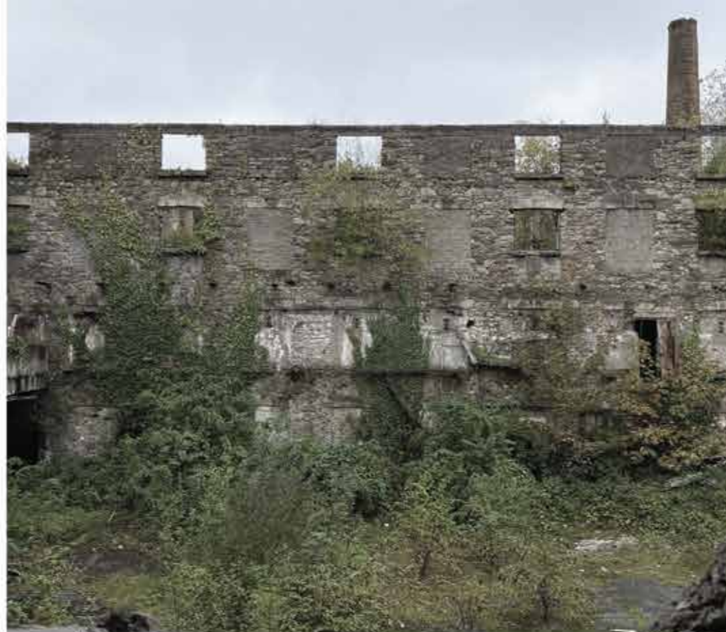
staršie kídlo objektu, pohľad na fasádu z nádvorja
