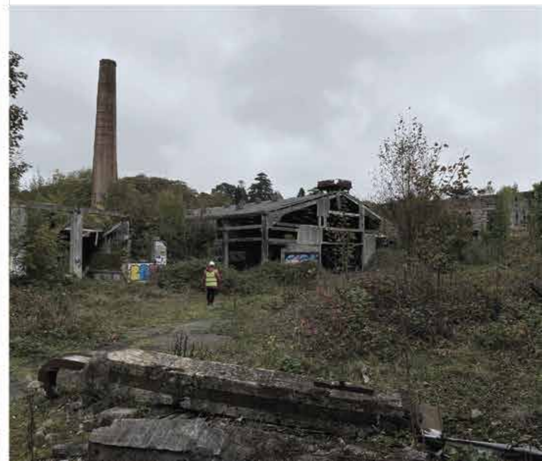
pohľad na halu a komín
