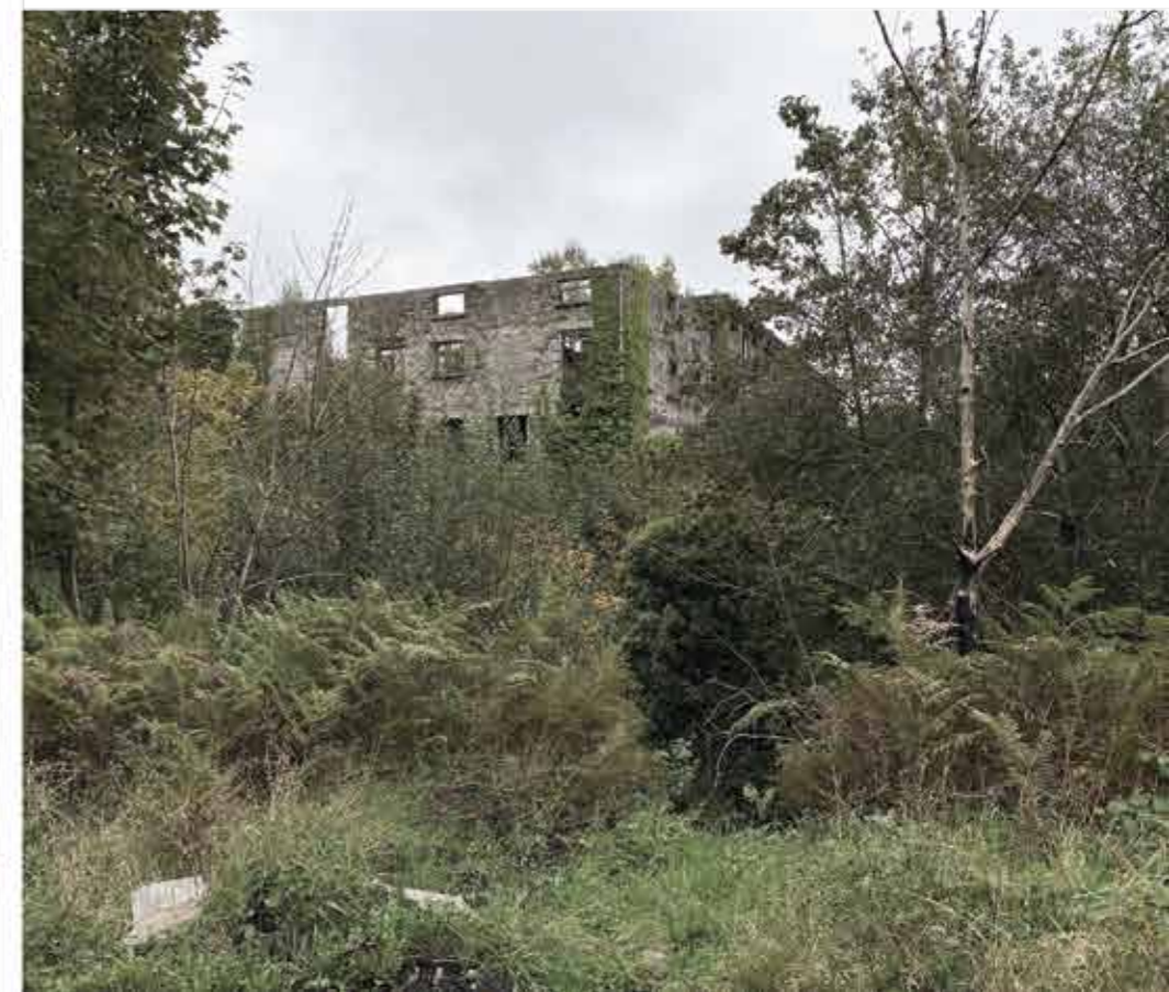
pohľad na staršie kídlo objektu z juhozápadnej strany
