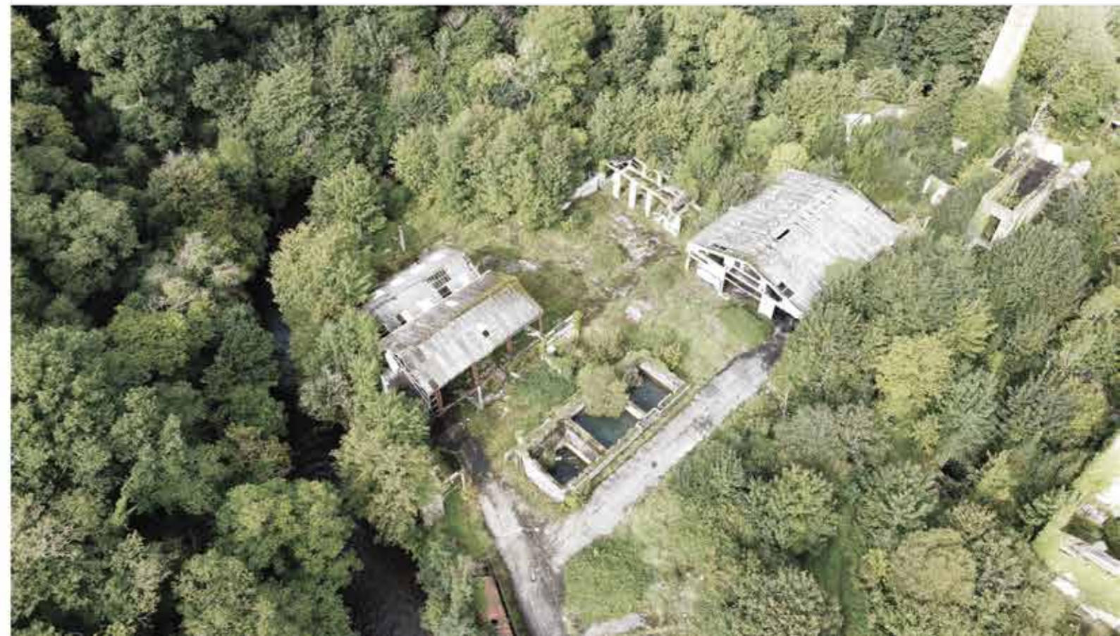
pohľad na vedľajšie objekty areálu (vodná nádrž, strojovňa, komín, haly)
