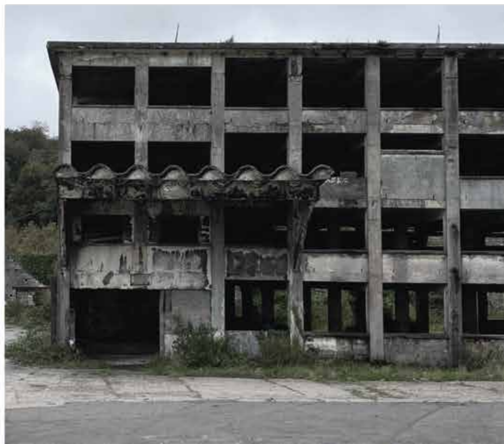
novšie kídlo objektu, pohľad na fasádu od prístupovej cesty (z východu)
