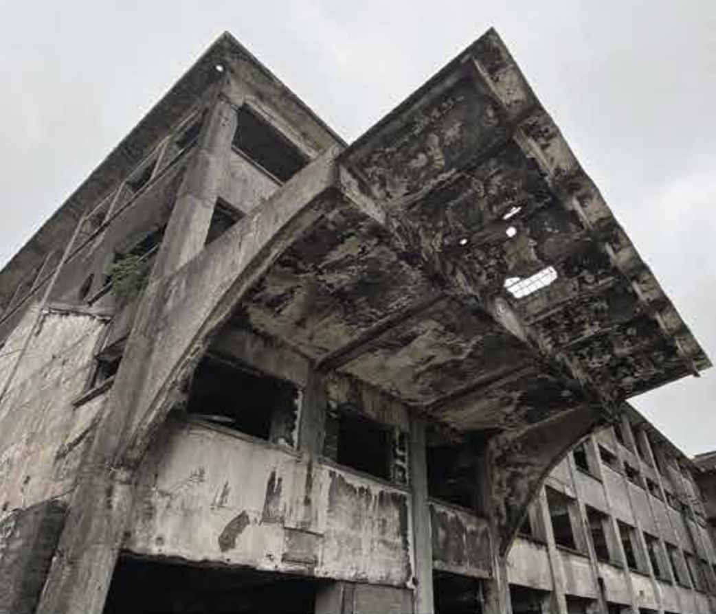
hlavný vstup objektu
