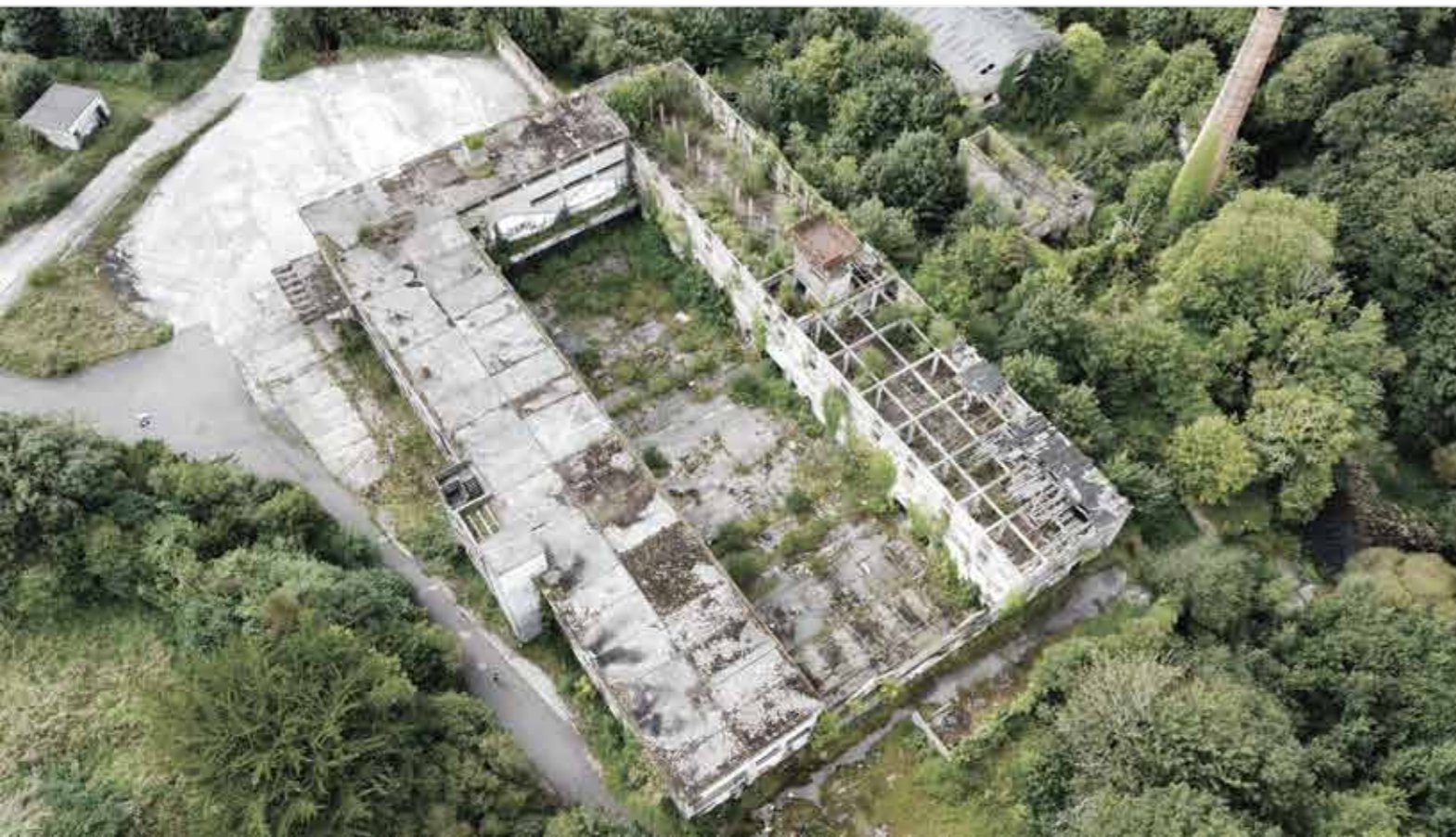
pohľad na hlavnú budovu bývalej továrne zo severovýchodnej strany
