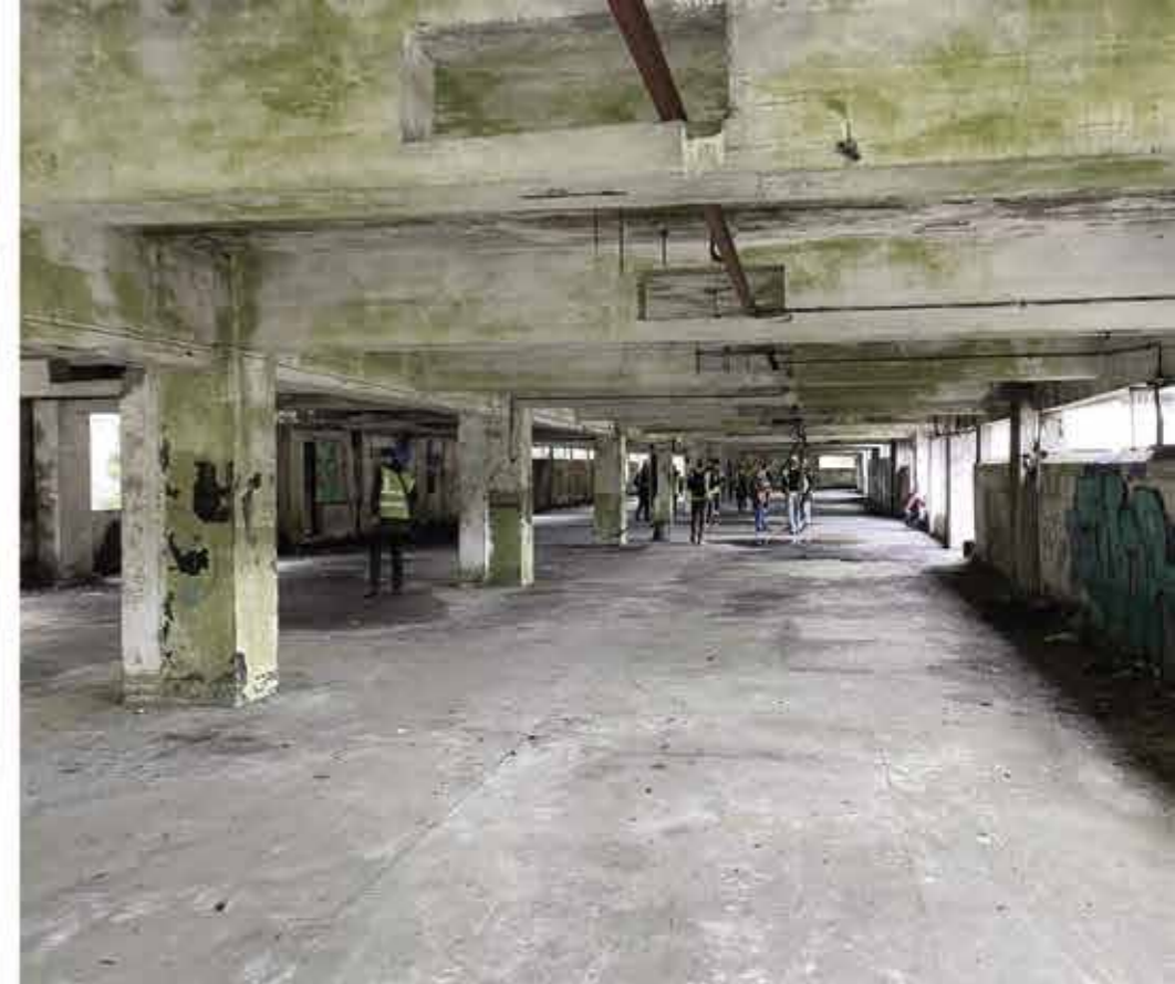
nosná konštrukcia novšieho kídla objektu, severná časť
