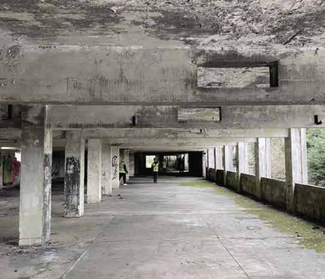
nosná konštrukcia novšieho kídla objektu, južná časť
