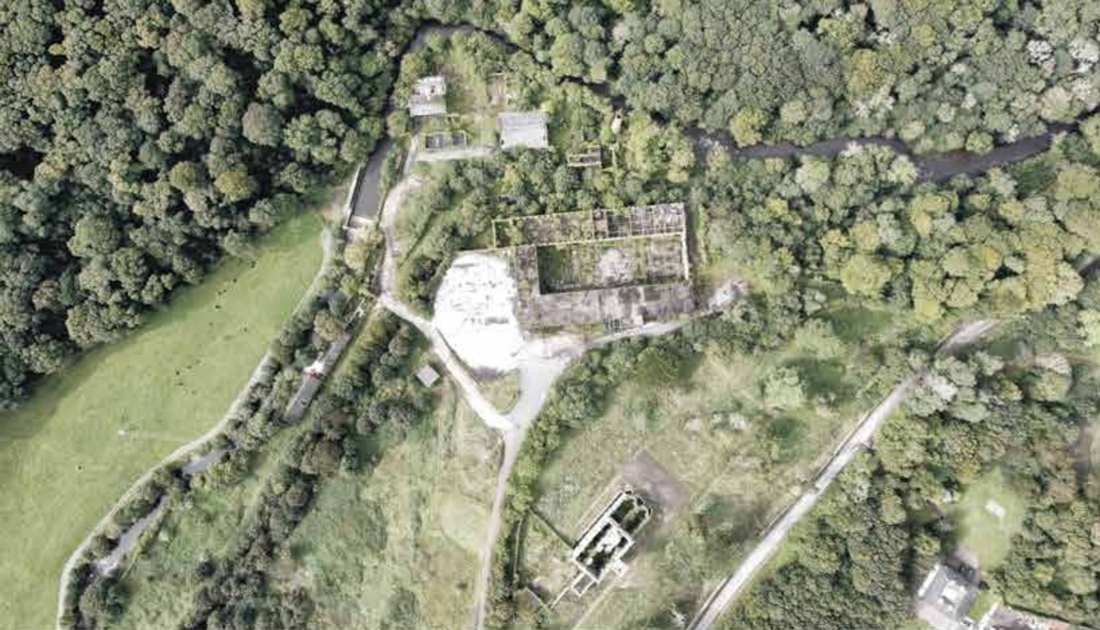
pohľad na riešené územie
