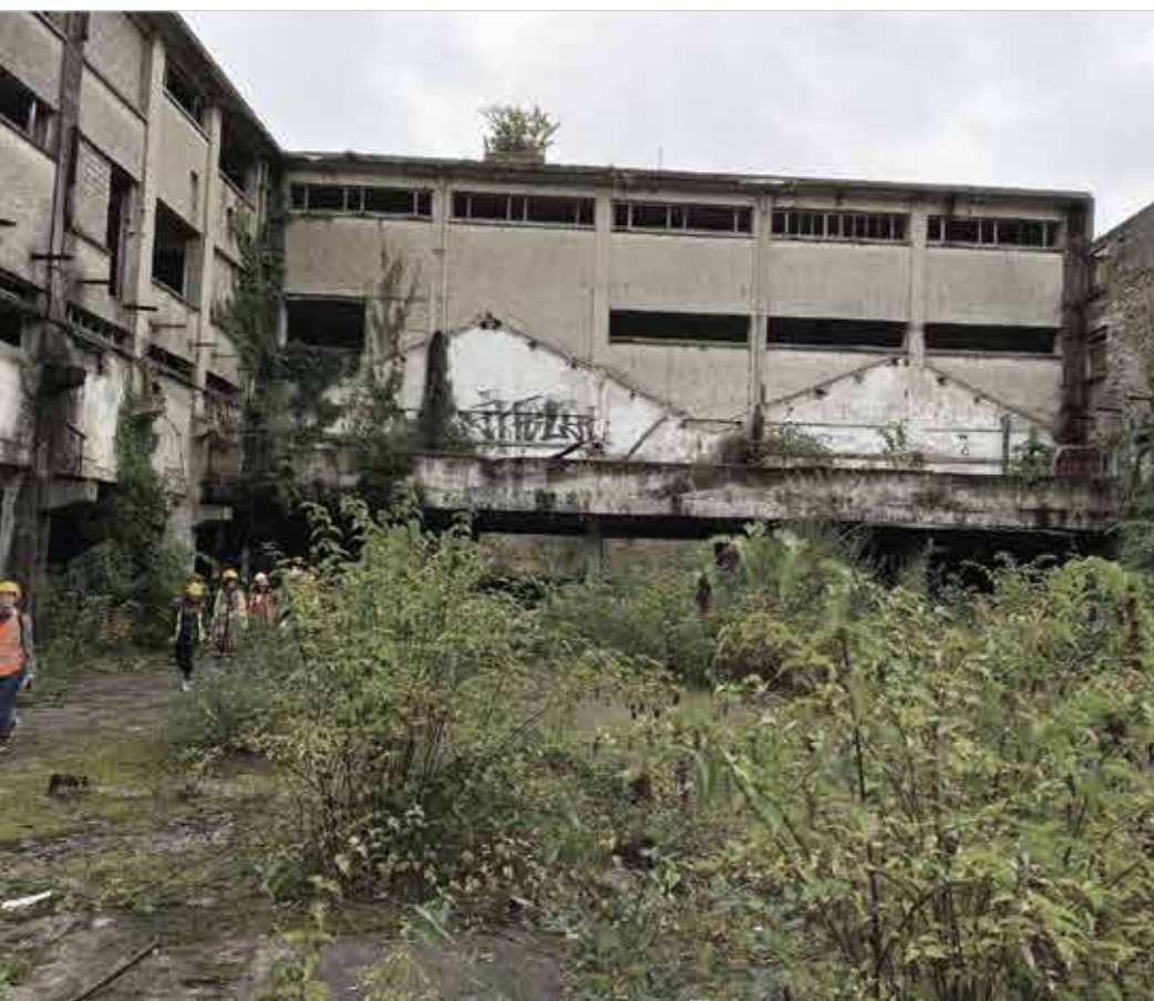
pohľad z nádvorja na juh; vpravo staršie kídlo objektu; vľavo novšie kídlo objektu
