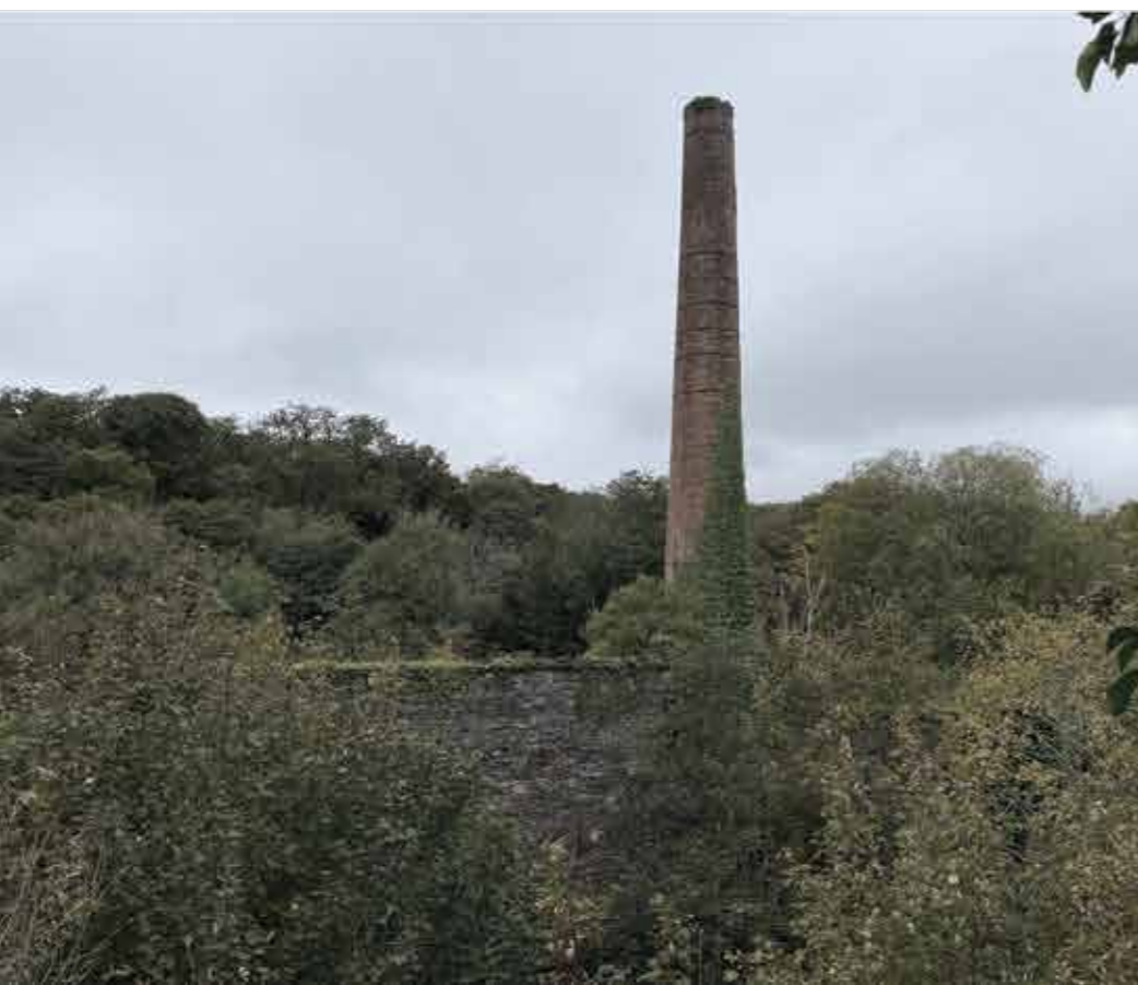
pohľad na komín z 3NP staršieho krídla hlavnej budovy
