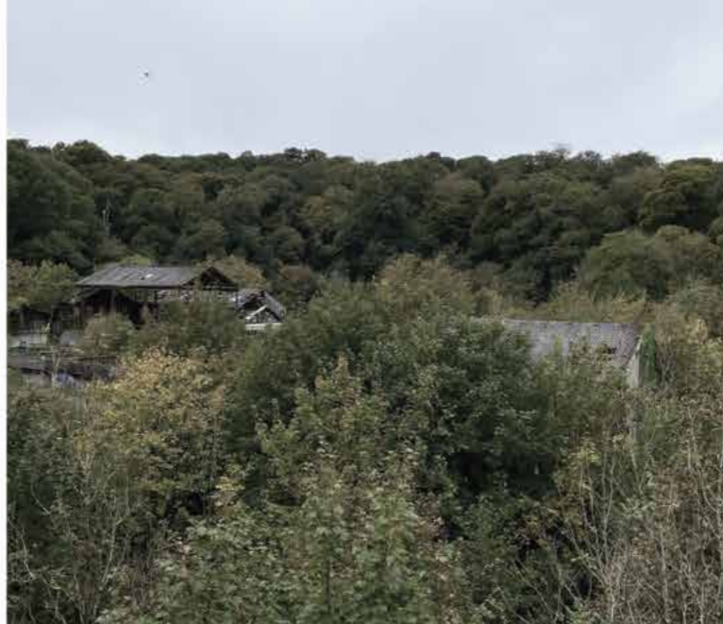
pohľad na haly z 3NP staršieho krídla hlavnej budovy
