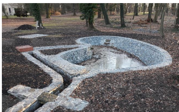
Obrázek č. 84: Retenční nádrž (SZ) – říjen 2017. (autor)
