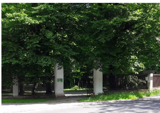
Obrázek č. 86: Severozápadní vstupní brána – květen 2017. (autor)
