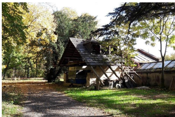
Obrázek č. 81: Severní pohled na torzo skleníku – říjen 2017. (autor)
