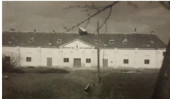
Obrázek č. 58: Pavilon naproti zámku – třicátá léta 20. století. (archiv obecního úřadu)
