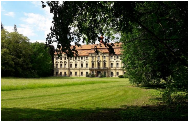
Obrázek č. 97: Pohled na jižní průčelí zámku – květen 2017. (autor)
