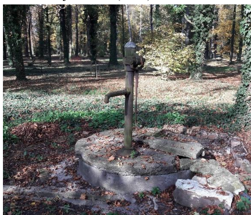
Obrázek č. 82: Pumpa severozápadně od skleníku – říjen 2017. (autor)
