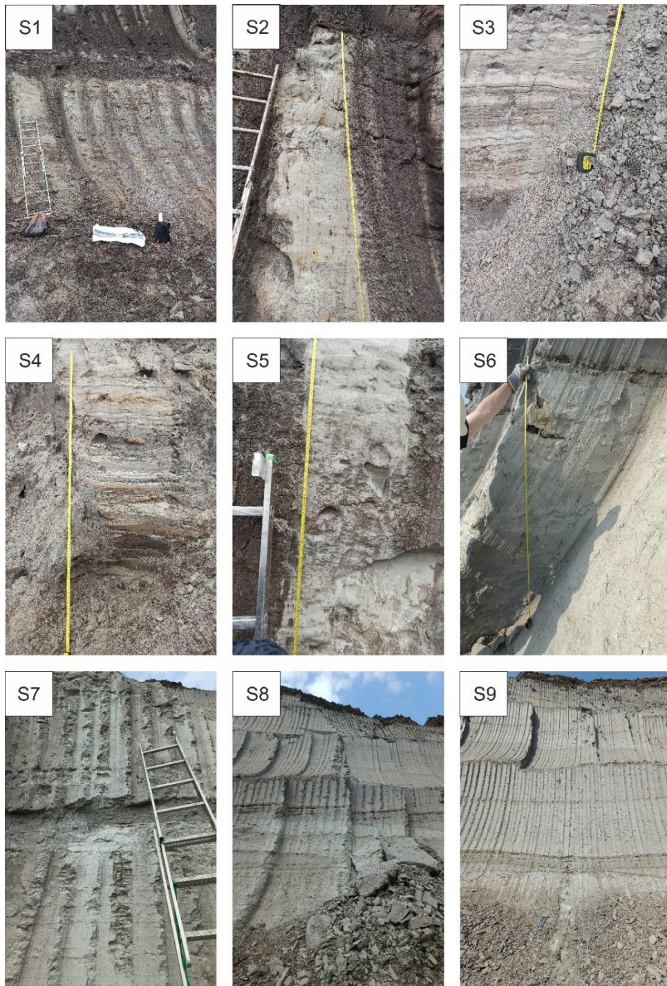
Obrázek 16: Fotokomentace sond stěny K99.
