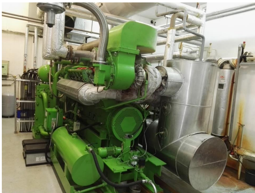
Obr. 13 - Kogenerační jednotka v Krásné Hoře
