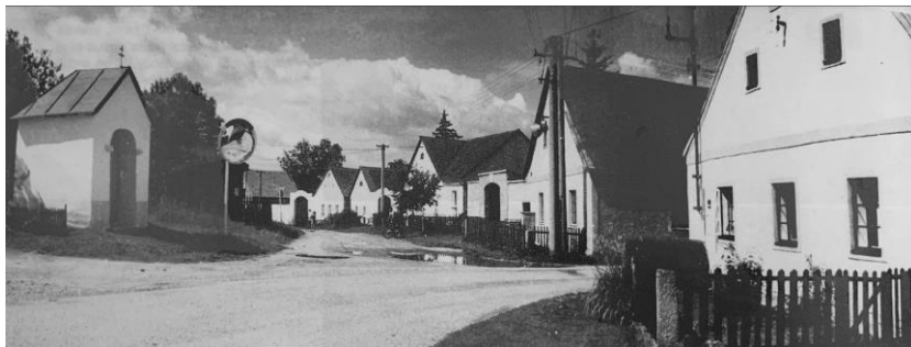
Obrázek 5 - Náves bez rušivého stavebního zásahu
