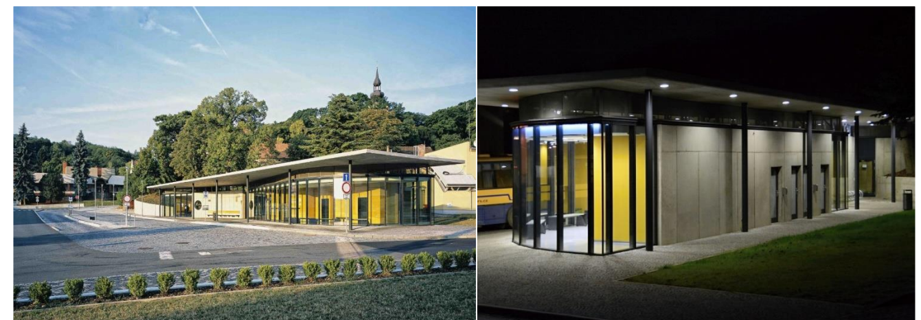
Obr. 85, 86: Autobusové nádraží v Klouboukách (stavbaweb)
