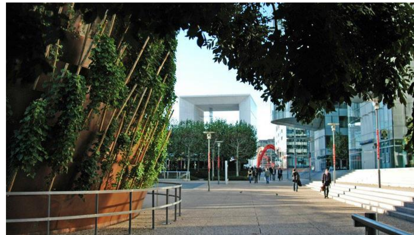
Obr. 29: Pohled na větrací komín a La Défense (greenroofs)
