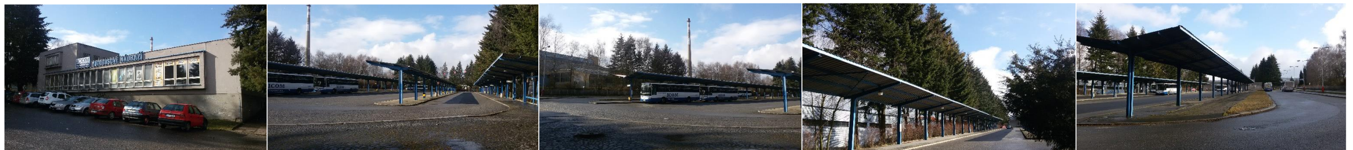
Obr. 56, 57, 58, 59, 60: Pohledy na celkový prostor autobusového nádraží v Humpolci (foto: autor, 2016)
