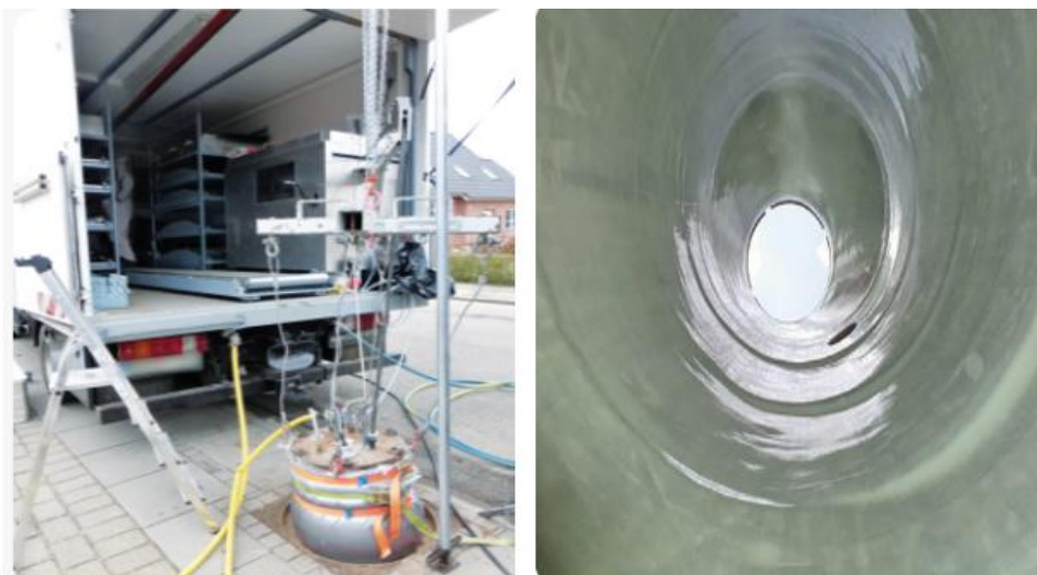
Obr. 2.26 Spouštění vložky (vlevo), vytvrzená vložka (vpravo) [36]
