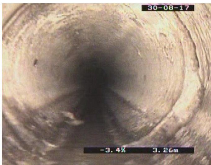
Obr. 4.17 Fotografie vychýlení (netěsnosti) potrubí na úseku 116957 [75]
