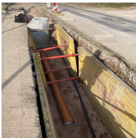
Obr. 2.3 Pokládka potrubí v zapaženém otevřeném výkopu [zdroj: Bc. K. Brychta]
