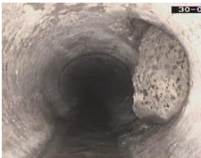
Obr. 4.18 Fotografie neodborně zaústěné přípojky na úseku 116957 [75]
