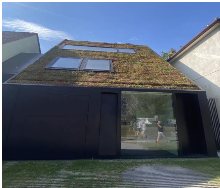
Obr. 3.2 Extenzivní zelená střecha ve Znojmě [zdroj: Bc. K. Brychta]
