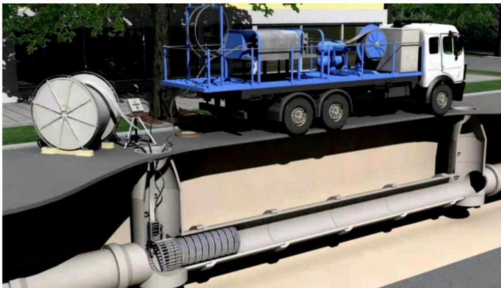
Obr. 2.19 Vystýlka z navíjených pásů místě [25]
