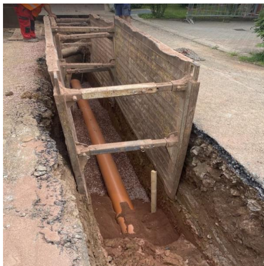
Obr. 2.12 Obnova potrubí v otevřeném výkopu [zdroj: Bc. K. Brychta]
