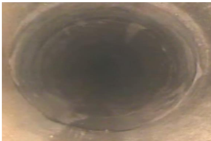
Obr. 4.21 Fotografie vychýlení ve spoji na úseku 116509 [75]
