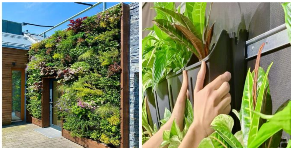
Obr. 3.6 Zelená stěna (vlevo) [48] a uchycení hydroponického truhlíku na stěně za pomoci lišty (vpravo) [49]
