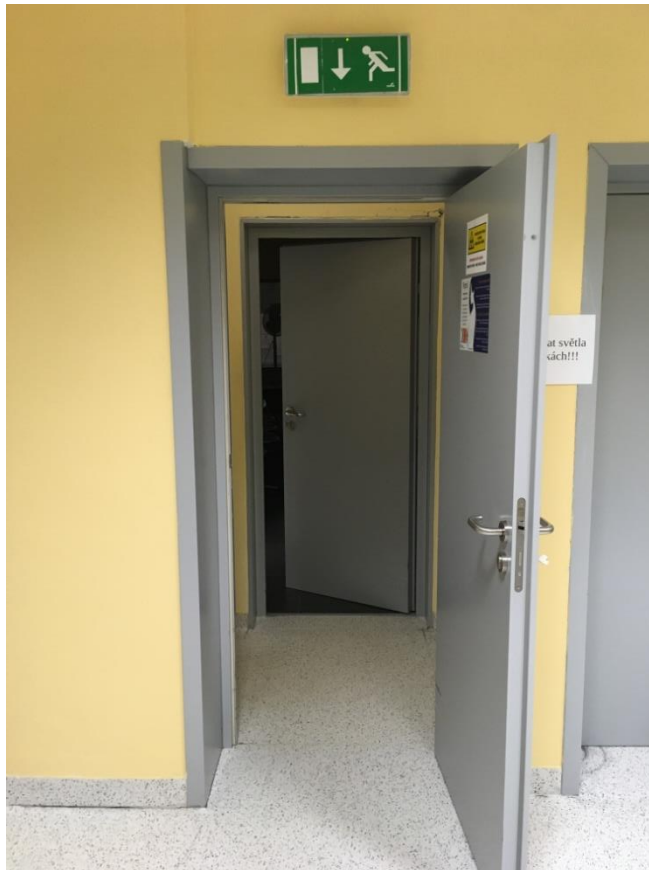
Obrázek 7- Ztížená průchodnost únikové cesty (svěšené panty u dveří)
