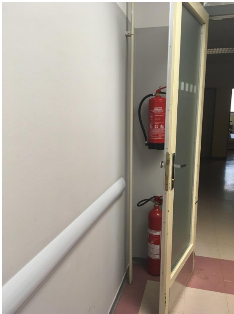
Obrázek 6-Špatné umístění hasicích přístrojů
