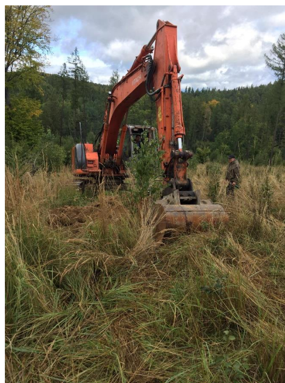
Obrázek 23: Štefan Vaľo při dozoru realizace opatření. Zdroj: Archiv autorky
