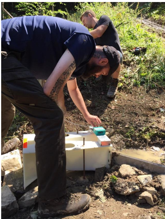
Obrázek 28: Matěj Horáček při instalaci žlabu. Zdroj: Archiv autorky
