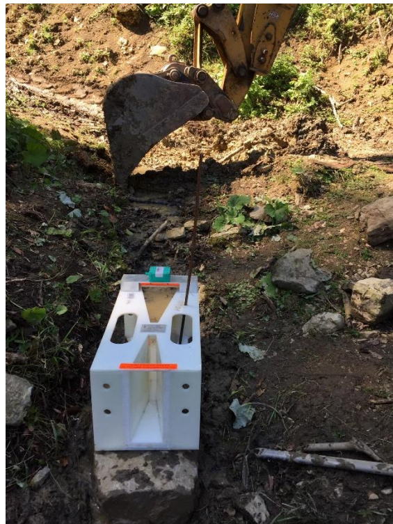
Obrázek 27: Příprava na instalaci žlabu. Zdroj: Archiv autorky
