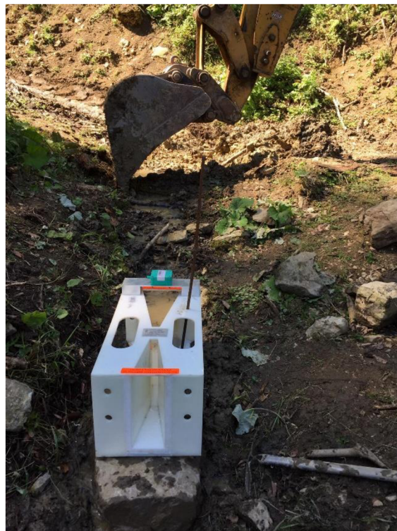
Obrázek 27: Příprava na instalaci žlabu. Zdroj: Archiv autorky
