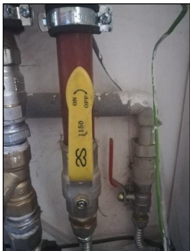
Obr. A.17 – Kulový kohout pro plyn (Obrázek z archivu autora)
