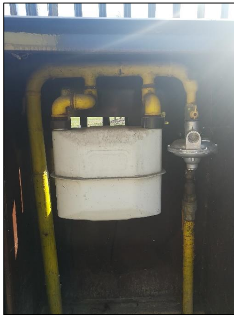
Obr. A.28 – Stávající řešení připojení regulátorů (Obrázek z archivu autora)
