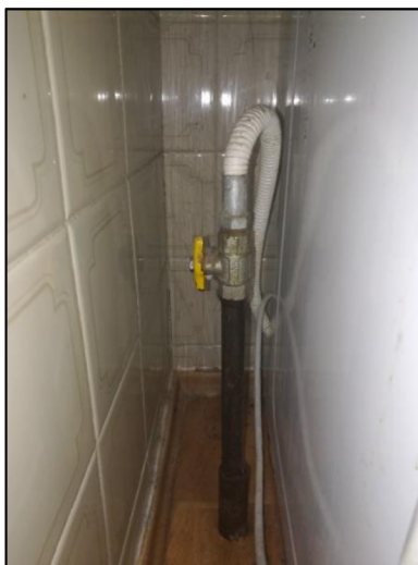
Obr. A.16 – Napojení plynového sporáku pomocí plynové hadice (Obrázek z archivu autora)
